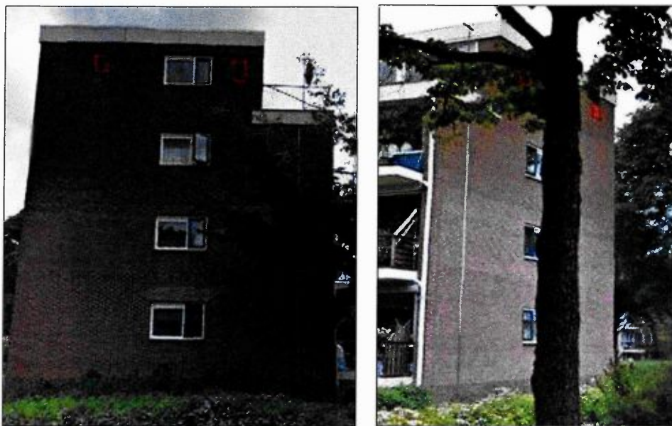
Afbeelding 6: Nieuwe locaties definitieve inbouwkasten ten behoeve van winterverblijfplaatsen op de westelijke kopgevel (links) en oostelijke kopgevel (rechts).
