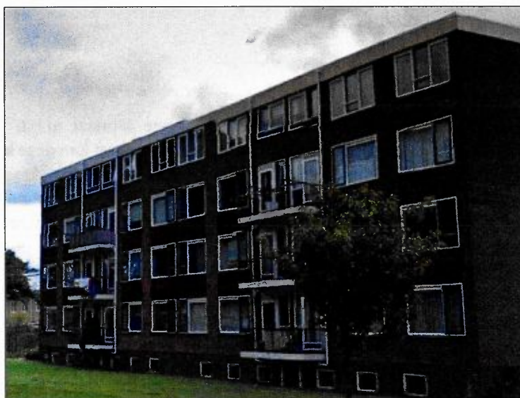
Afbeelding 5: Noorzijde van het flatgebouw met veel raampartijen en balkons.
