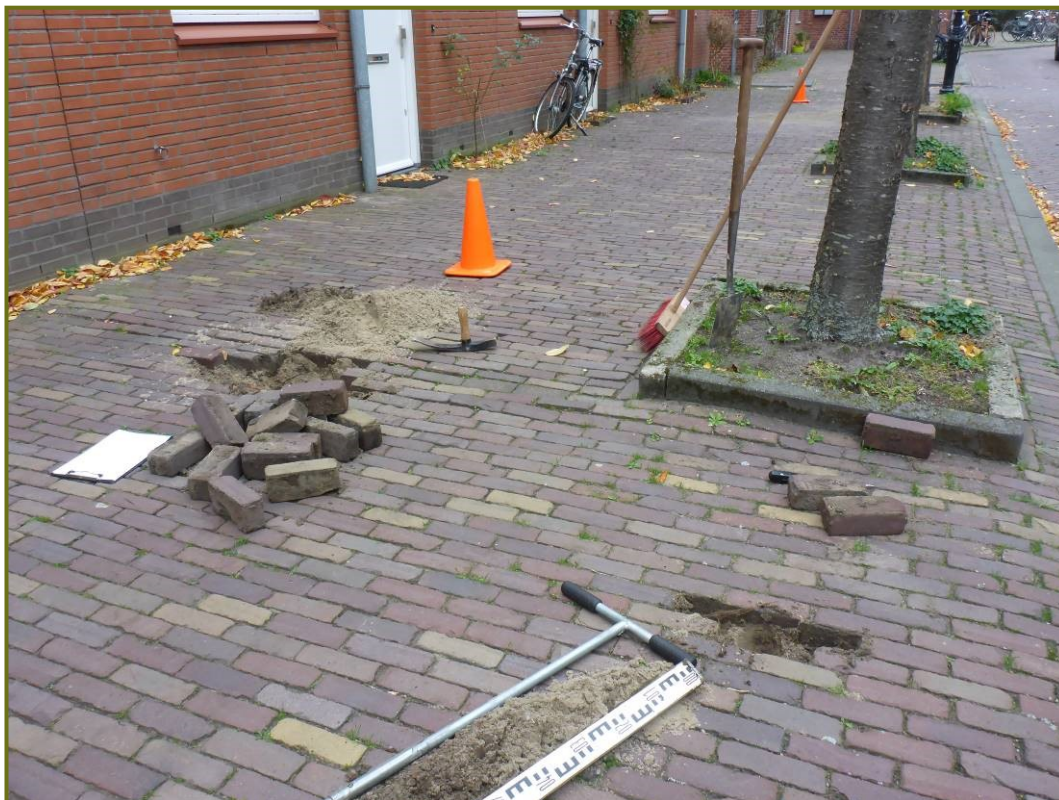
Afbeelding 9. Profielkuil 3 en grondboring 4 bij boom 7
