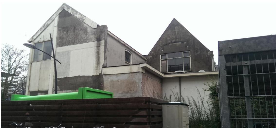
Figuur 6 Achterzijde gebouw R
