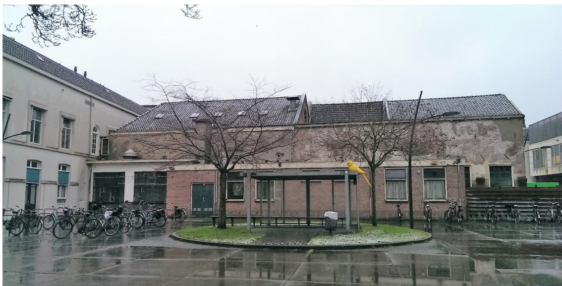
Figuur 5 Achterzijde Lange Nieuwstraat, deelgebied Museumhotel, met zicht op te slopen gebouw R
