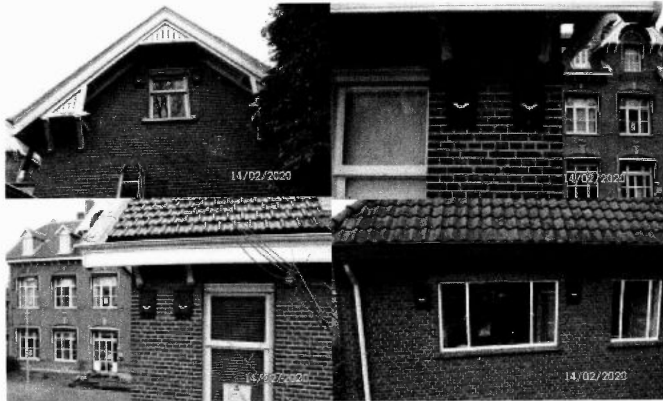
Figuur 5: foto's van de adit opgehangen tijdelijke vleermuiskasten als compensatie voor de aangetroffen paarverblijven.
