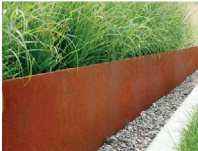
Grondkering/opstaande randen/ hekwerk cortenstaal
