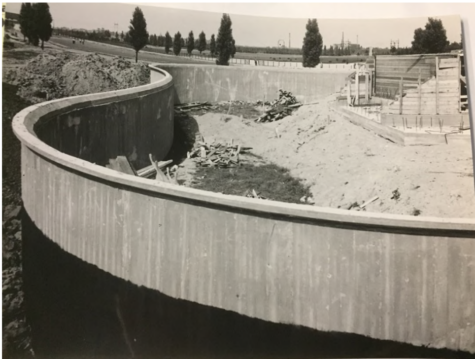
De betonnen keerwand tijdens de bouw
