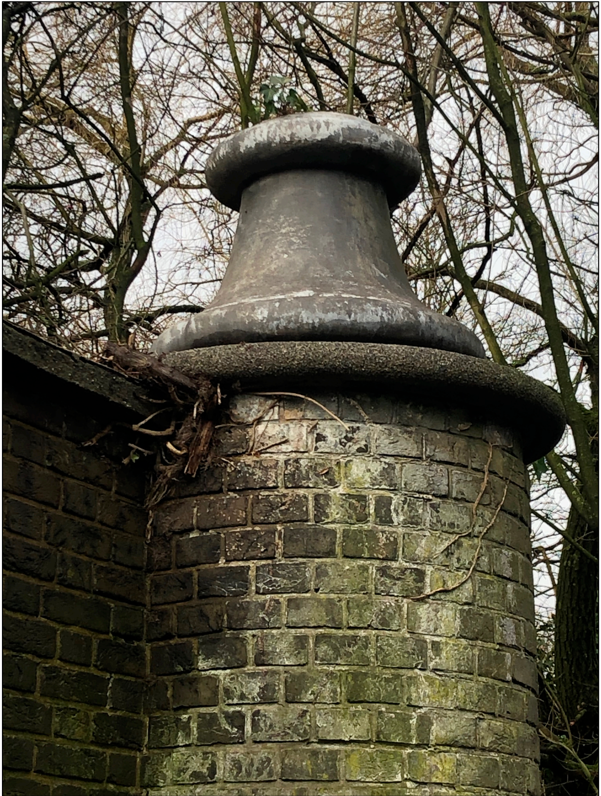
Een van de gemetselde pylonen met afdekking in beton en zink, januari 2019
