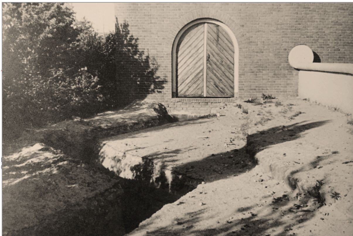
Bergdierenrots in 1940, achtermuur aan de westzijde met houten kozijn en de dubbele houten deuren (Archief Diergaarde Blijdorp)
