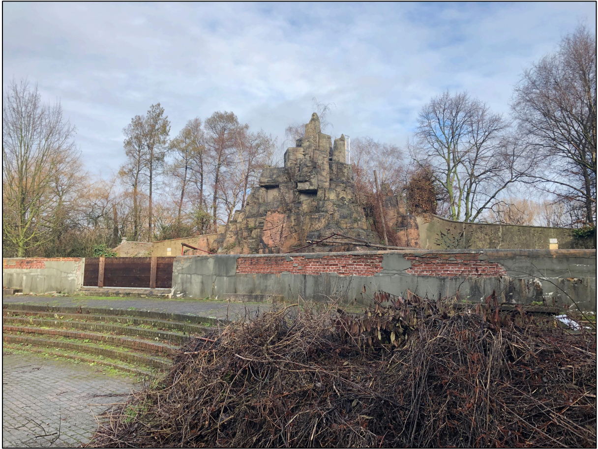
Bergdierenrots, situatie januari 2019, gezien vanuit het zuiden
