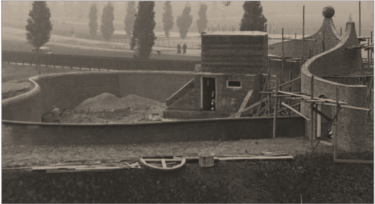
De bergdierenrots in aanbouw, november 1939: links de betonnen rand, in het midden de dienstruimten en rechts de achtermuur in schoon metselwerk (Foto Nationaal Archief/Polygoon)
