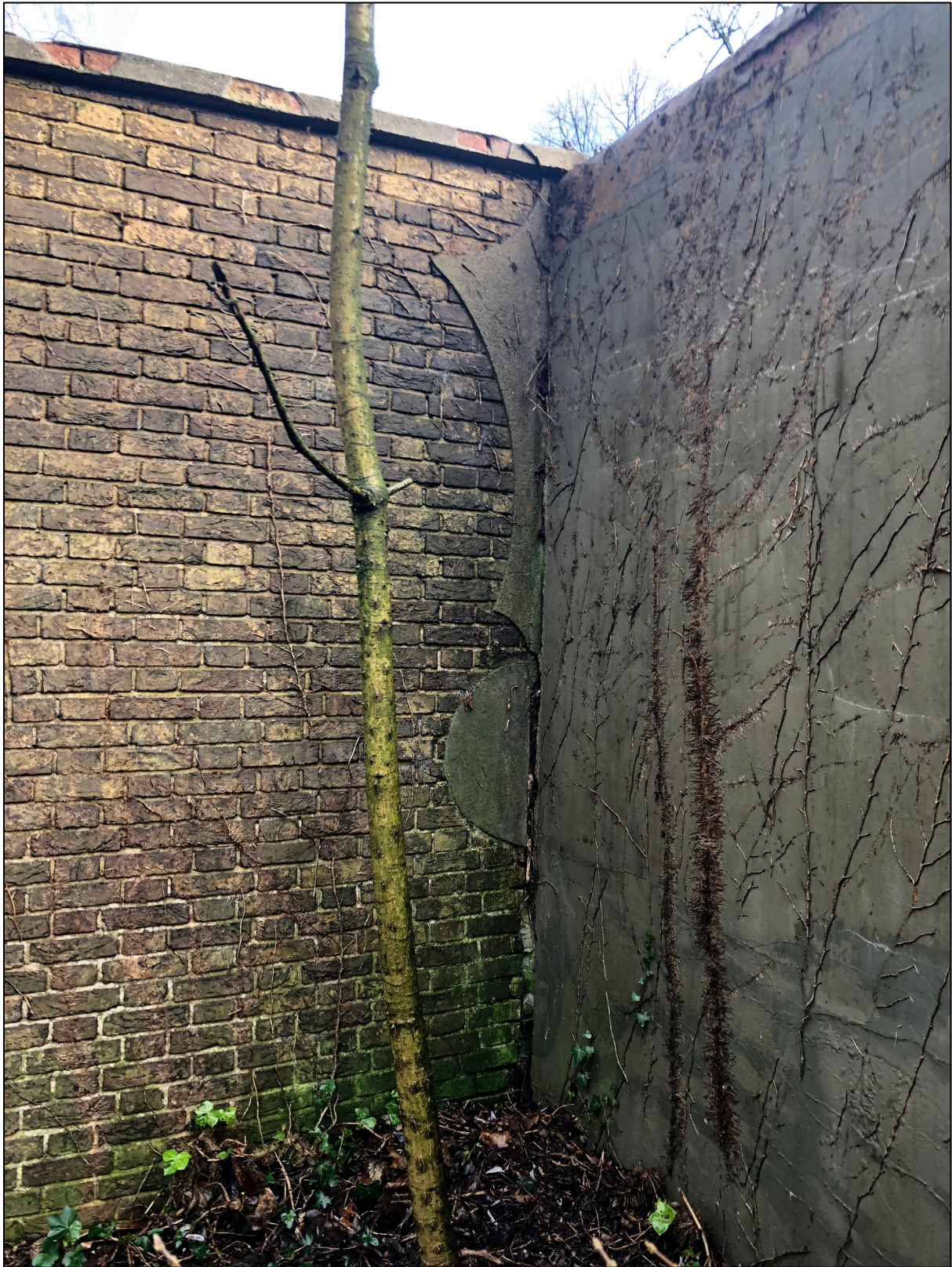
Bergdierenrots, situatie januari 2019, detail westelijke doorgang naar het achterterrein, rechts de opgehoogde perkrand; op het metselwerk in kettingverband van de achtermuur is plaatselijk een pleisterlaag aangebracht.
