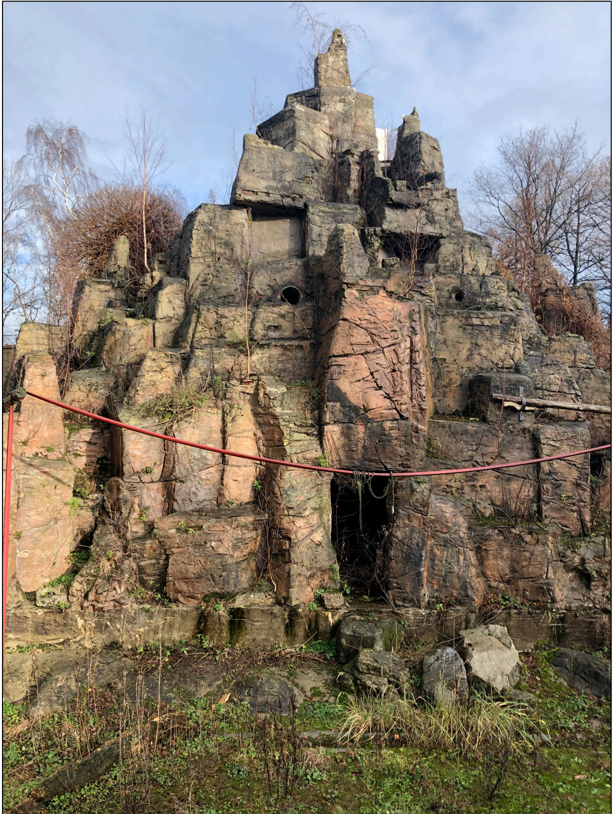
Bergierenrots met toegang naar betonnen dienstverblijf, januari 2019
