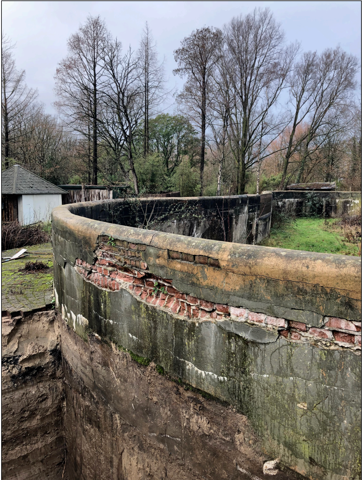
Detail opgemetselde betonnen rand, situatie januari 2019
