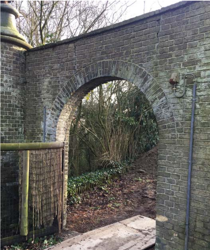
nr: 35 toelichting: Poort achterzijde plaats: Achterwand achterzijde
