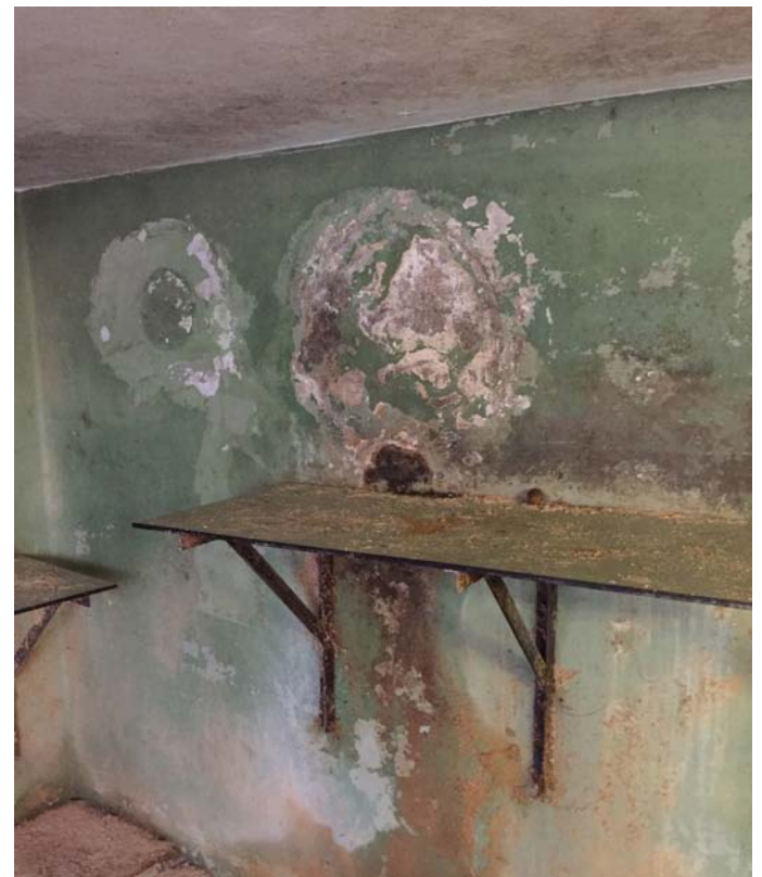
nr: 32 toelichting: origineel raamopeningen dichtgezet plaats: Interieur dierenverblijf
