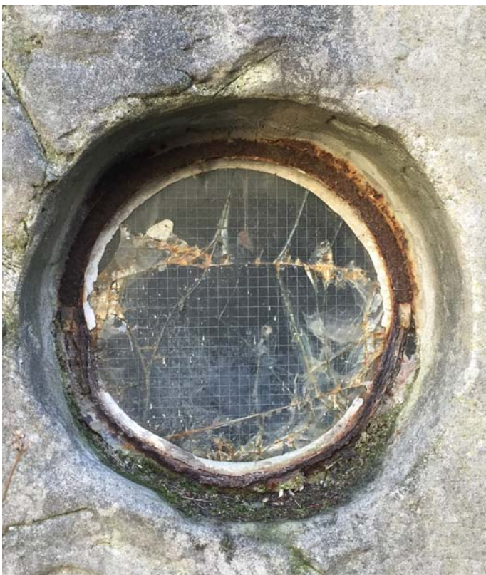
nr: 27 toelichting: Ronde ramen geheel geroest plaats: Rots achterzijde
