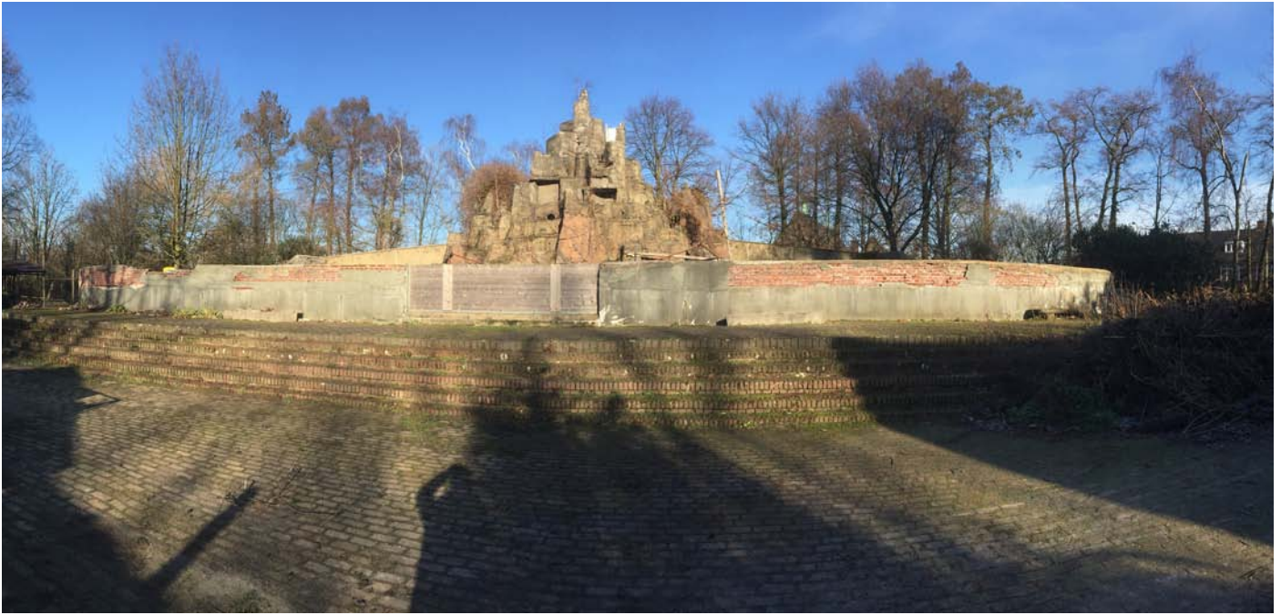
nr: 1 toelichting: Overzicht plaats: Vooraanzicht keerwand en rots
