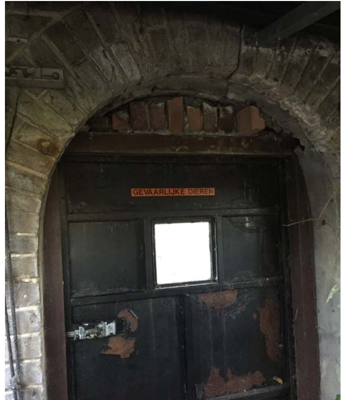
nr: 40 toelichting: Originele boog dichtgezet, nieuwe deur plaats: Achterwand achterzijde
