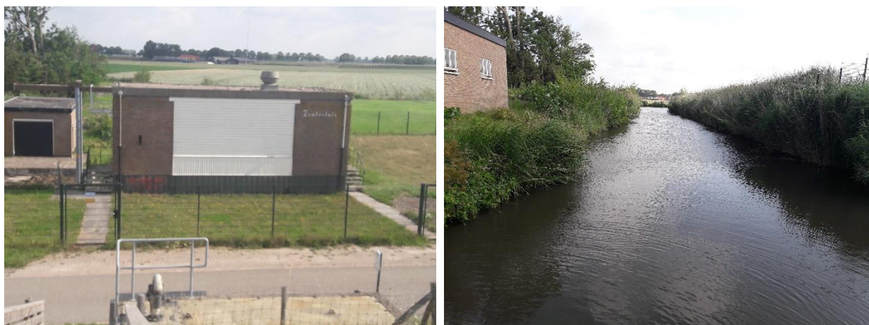
figuur 5.2.: projectlocatie gemaal Zoute Sluis gezien vanaf de dijk en het gemaal
