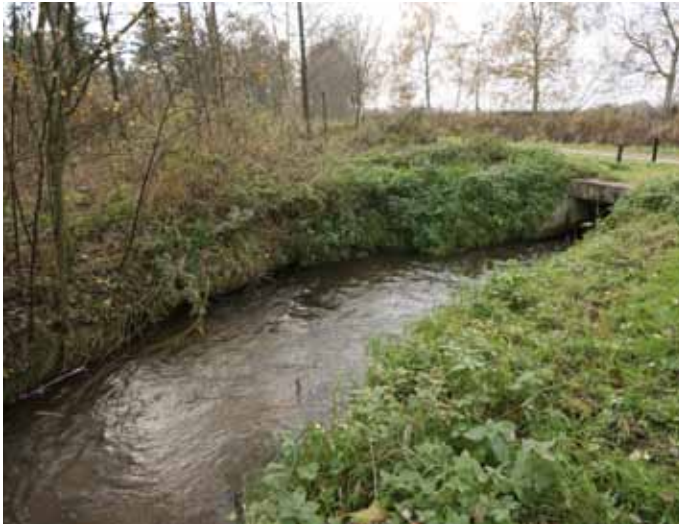
Figuur 9.1 | De traploze nevenbeek bij stuw Westerhoven in de Keersop heeft twee instroomopeningen. Eén voor grote afvoeren met een duiker onder de weg door en één via een De Wit-vispassage om het extra peilverschil tussen zomer- en winterpeil op te vangen. De uitstroomopening hiervan ligt onder de overhangende vegetatie van de tegenoverliggende oever.
