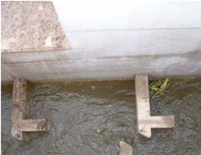
Figuur 12.4 | Slots in één lijn in vispassage Tweegelanden in de Aa of Weerijs.
