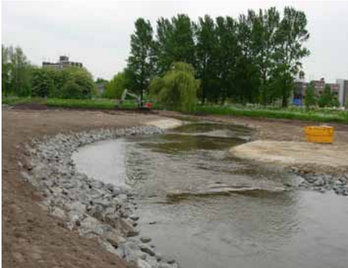
Figuur 10.22 | Verstevinging met stortstenen van de volledige oever van buitenbocht in vispassage Zaartpark in Aa of Weerij's tijdens uitvoering in 2005; binnenbochten en rechte stukken zijn alleen bij de overlaten verstevigd.
