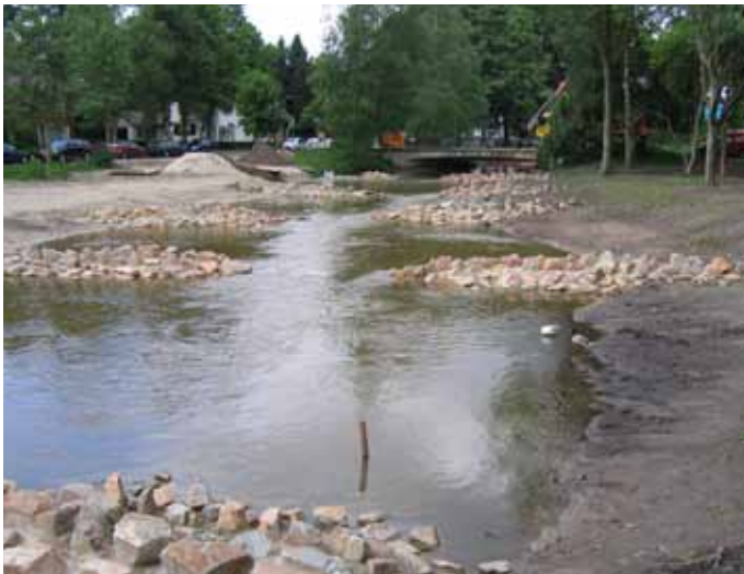
Figuur 10.1 | Door het diepste punt van de 'v' verspringend en asymmetrisch aan te leggen ontstaat in de bekkens een langere stroomdraad met meer variatie in stromingspatronen.
