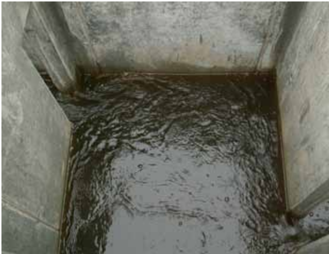
Figuur 12.5 | Verspringende slots in vertical slot vispassage Everlanden in de Molenbeek.
