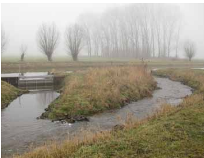
Figuur 8.3 | Dubbele instroomopening in de bekkervispassage 't Ham in De Aa; links de afsluitbare 'winteropening' en rechts de 'zomeropening'.
