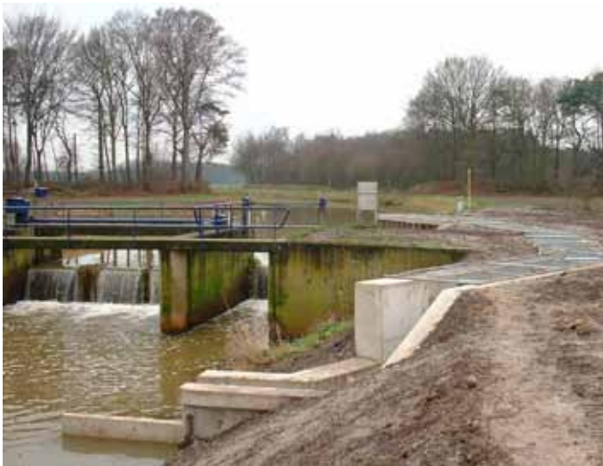
Figuur 12.1 | Vertical slot vispassage Tweegelanden in de Aa of Weerij. De doorlopende betonnen wand en de vorm ervan zorgen voor een goede geleiding van de lokstroom, waardoor vissen de vispassage goed weten te vinden.
