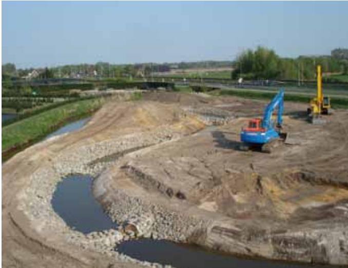
Figuur 8.2 | In 2011 is in de Kleine Aa bij Boxtel door waterschap De Dommel in een beekherstelproject een bekkervispassage aangelegd. Door de lokale onstabiele grondslag bleek het noodzakelijk de oevers over grote lengte met stortsteen te verstevigen. De gewenste morfologische processen zullen daardoor maar beperkt optreden.
