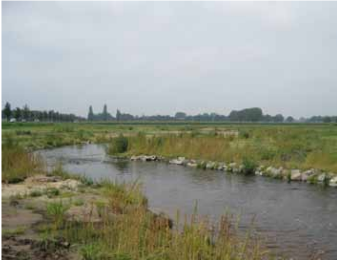
Figuur 10.24 | Het rustige, gevarieerde stroombeeld over de drempels suggereert een goed functioneren van de vispassage in de Kleine Aa bij de Kapelweg.
