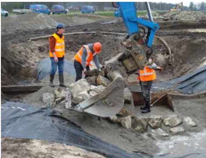
Figuur 10.15 | Instrueren van de aannemer bij het opbouwen van een drempel.
