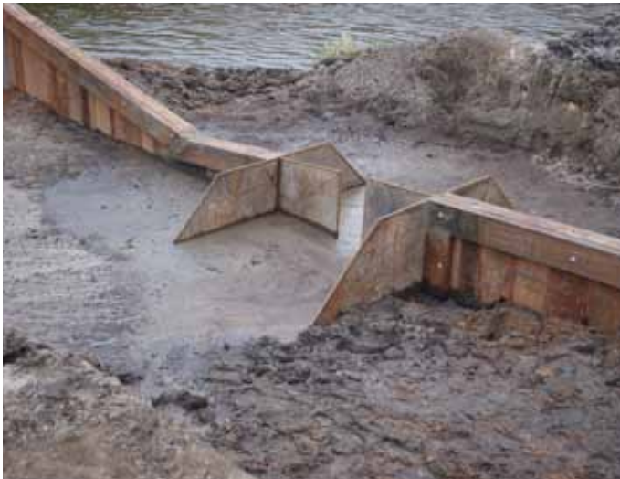
Figuur 10.9 | Metalen damwandbak met verticaal slot ingebouwd in de damwand van een drempel in aanbouw.
