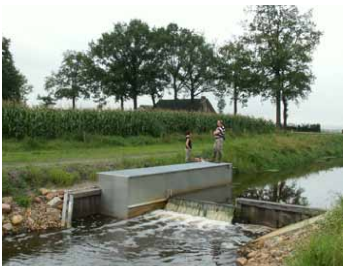
Figuur 13.4 | De Wit-vispassage met schotbalkstuw in de Kleine Beek bij de Achtmaalseweg.
