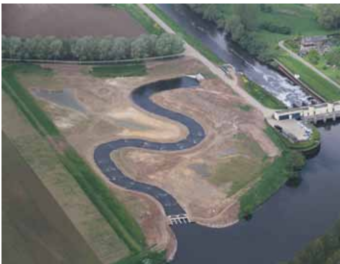
Figuur 10.25 | Vispassage Crèvecoeur tijdens de aanleg in november 2011.
