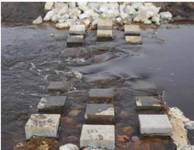
Figuur 10.20 | Detail van één van de drempels in de Kaweise Loop.
