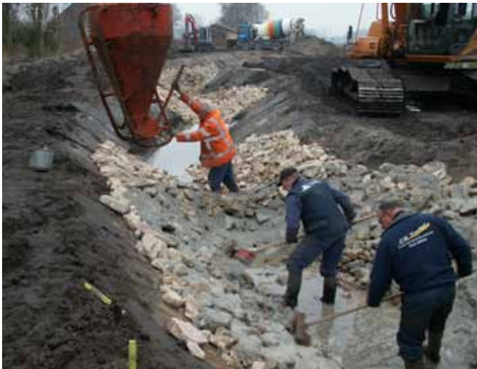
Figuur 10.17 | In vispassage Galderse Beek wordt met bezems het beton tussen de stortstenen gewerkt, zodat een deel van de stenen boven het beton uitsteekt.
