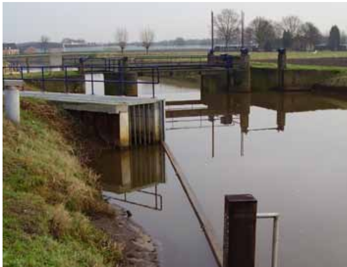
Figuur 12.11 | Drijfbalk en drijfvuilrooster voor vertical slot vispassage Tweegelanden in de Aa of Weerij.
