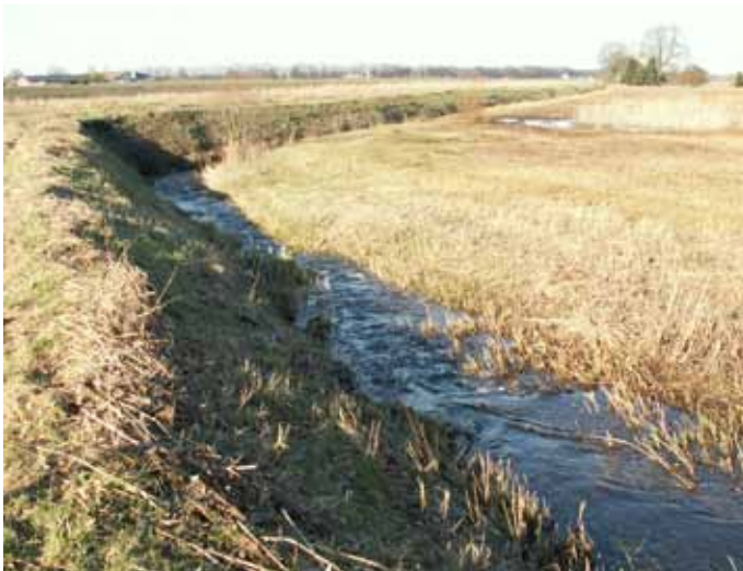
Figuur 11.3 | Stenen hellingvispassage bij Riels Hoefke in de Boven Donge in februari 2010. De stenen liggen onder de waterspiegel.
