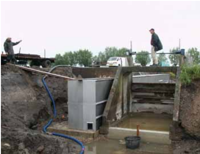
Figuur 13.3 | De uitstroomopening in de 10 graden gedraaide wand van een De Wit-vispassage bij stuw Biggelaar in de Kleine Beek.
