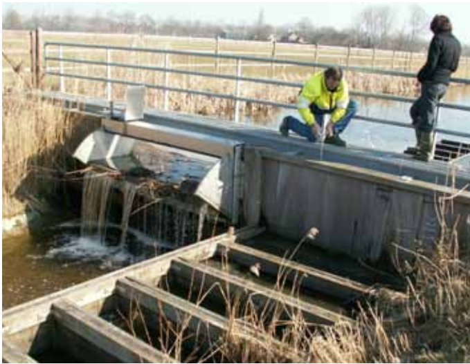
Figuur 13.5 | De Wit-vispassage in de Aalskreek met benedenstrooms kamers van hout en bovenstrooms een metalen constructie.
