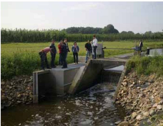
Figuur 5.1 | De Wit-vispassage zonder reling
