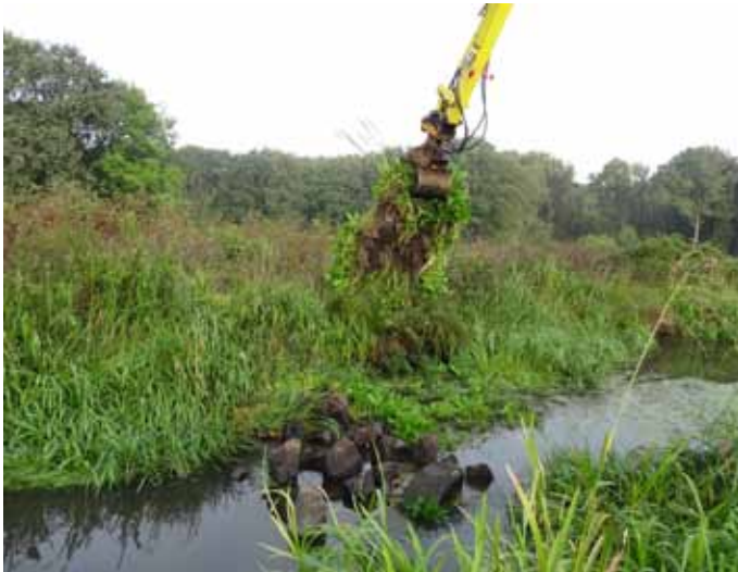
Figuur 10.14 | Onderhoud met een kraan met knijper is een Arbo-verantwoord alternatief voor handmatig onderhoud. Er dient dan echter wel een obstakelvrije zone langs de vispassage aanwezig te zijn.
