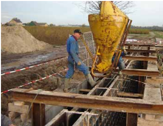
Figuur 12.10 | Storten van beton bij de aanleg van vertical slot vispassage Wernhout in de Aa of Weerij.
