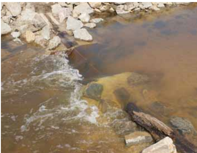
Figuur 10.2 | Aanzanding op een drempel verslechtert de mogelijkheden voor vismigratie doordat het de doorzwemhoogte vermindert.
