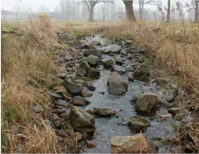
Figuur 11.1 | Voorbeeld van een stenen hellingvispassage in de Grootte Heikantsche beek (onderdeel van Chaamse bekenstelsel).
