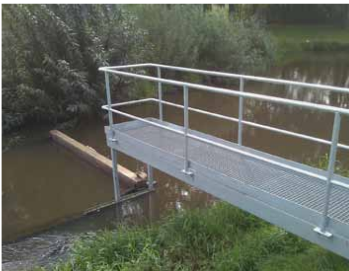
Figuur 5.4 | Loopbrug waarmee dichtzetconstructie makkelijker en veiliger bediend kan worden.
