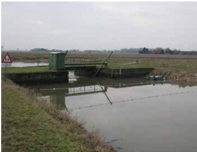
Figuur 15.3 | Ingegraven Hevelvispassage bij de stuw Oijense Hut in de Hertogswetering.
