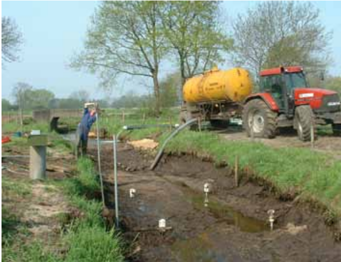
Figuur 4.1 | Akoestische meetinstallatie tijdens aanleg van vispassage in het Merkske.
