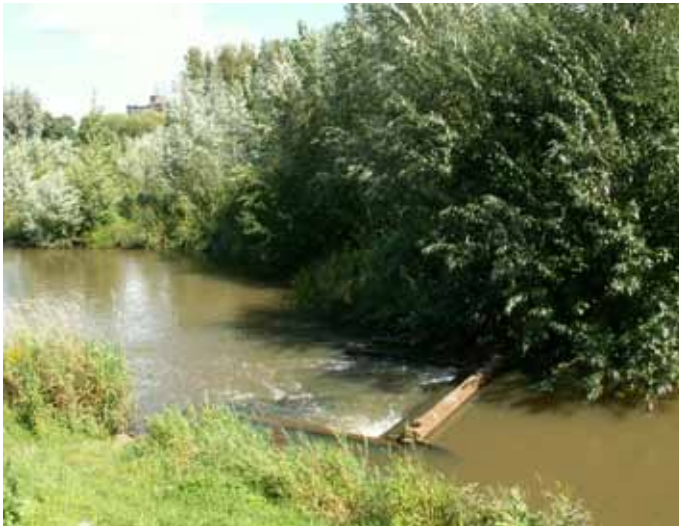
Figuur 5.2 | V-vormige bekkenvispassage met 'onbereikbare' dichtzetconstructie.
