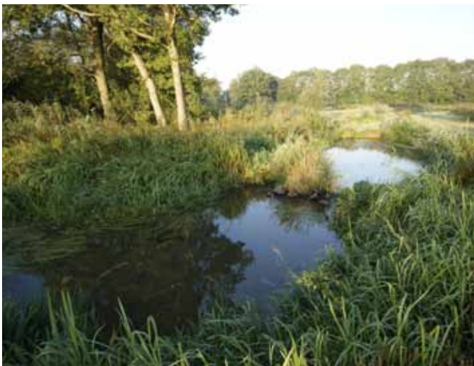
Figuur 10.12 | Doordat er in deze bekkervispassage veel stortsteen op de oevers en de drempel is aangebracht, is machinaal en efficiënt maaionderhoud nauwelijks mogelijk. Daardoor is er veel begroeiing, waardoor de vispassage nauwelijks meer functioneert.
