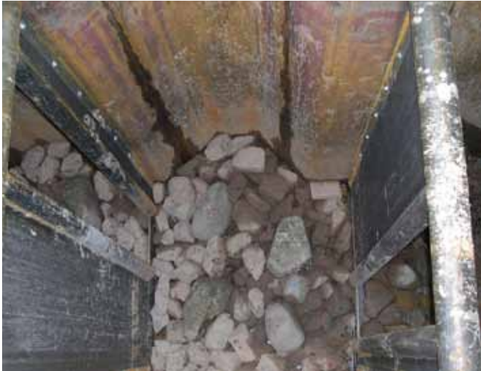
Figuur 12.6 | Afgeronde slots in een kamer van vertical slot vispassage Egeldonk in de Aa of Weerij
