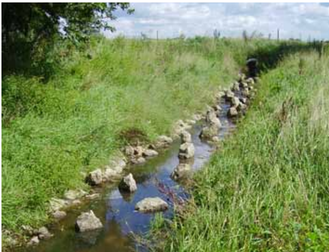
Figuur 11.2 | Voorbeeld van een stenen hellingvispassage in de Strijbeekse Beek.
