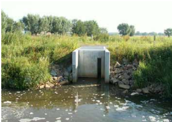
Figuur 12.3 | Versteviging van de oevers bij de uitstroomopening van vertical slot vispassage Everlanden in de Molenbeek.
