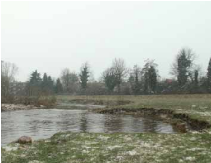
Figuur 10.23 | Vispassage Zaartpark in Aa of Weerij's vijf jaar na aanleg met erosie van oever waar verstevinging met stortstenen ontbreekt.
