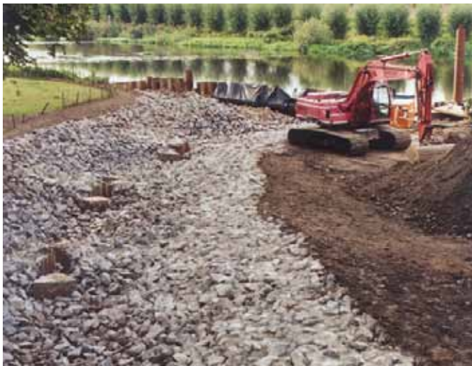
Figuur 10.28 | Aanleg van de vispassage om de Vughterstuw. De vertical slots (damwand) en grote stoorstenen voor en achter de slots zijn goed zichtbaar.
