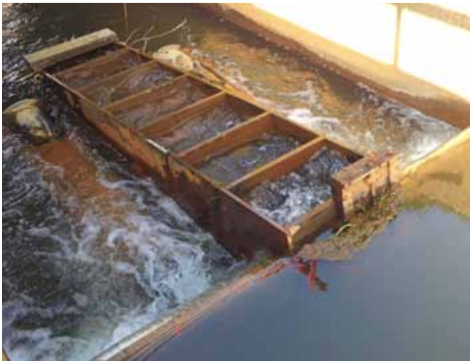
Figuur 14.1 | Meyberg-vispassage in de St. Anthonisloop.
