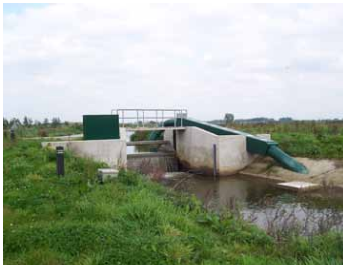
Figuur 15.2 | Hevelvispassage bij de stuw Berghem in Hertogswetering, vlak na aanleg. Rechts is de inzwembak te zien.
