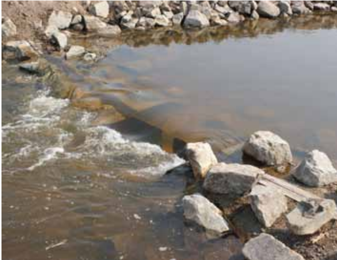
Figuur 10.4 | Specifieke aanpassingen in het drempelontwerp zorgen ervoor dat deze ook vispasseerbaar zijn bij lage afvoeren: een steile(re) helling met een ondiepe vertical slot.
