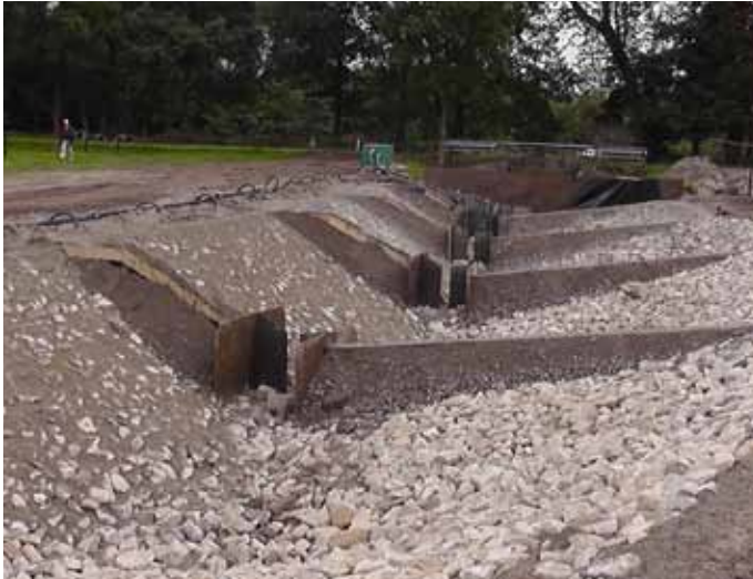
Figuur 10.11 | Drempels met een kern van zand in de opbouwfase in de Molenbeek bij de Oude Turfvaartsestraat.
