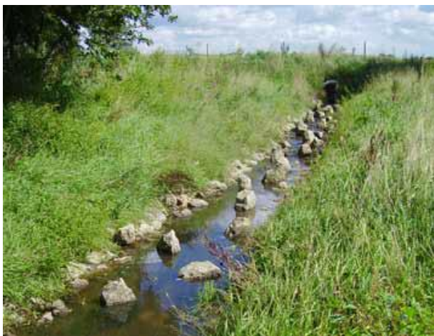
Afbeelding 2.4 Voorbeeld van een stenen hellingvispassage in de Strijbeekse Beek Bron; Handreiking vispassages in Noord-Brabant
