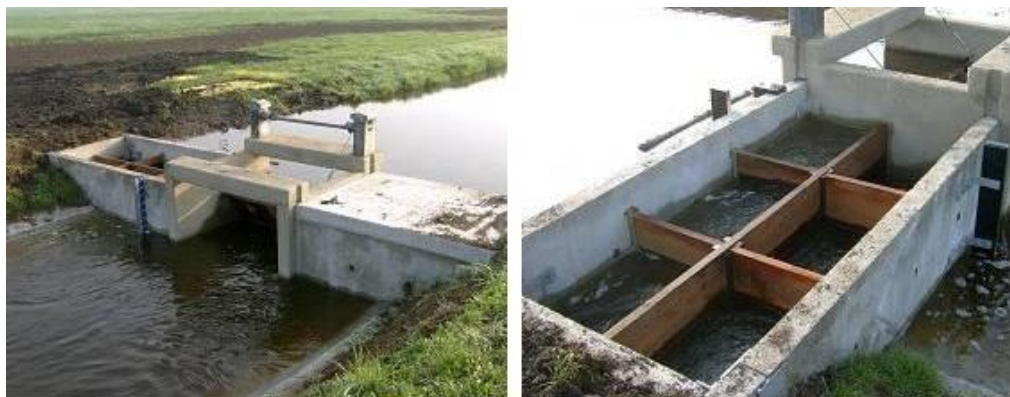
Afbeelding 2.7 Schutte-passage (zonder afdekplaat) (foto's: waterschap Groot Salland)
