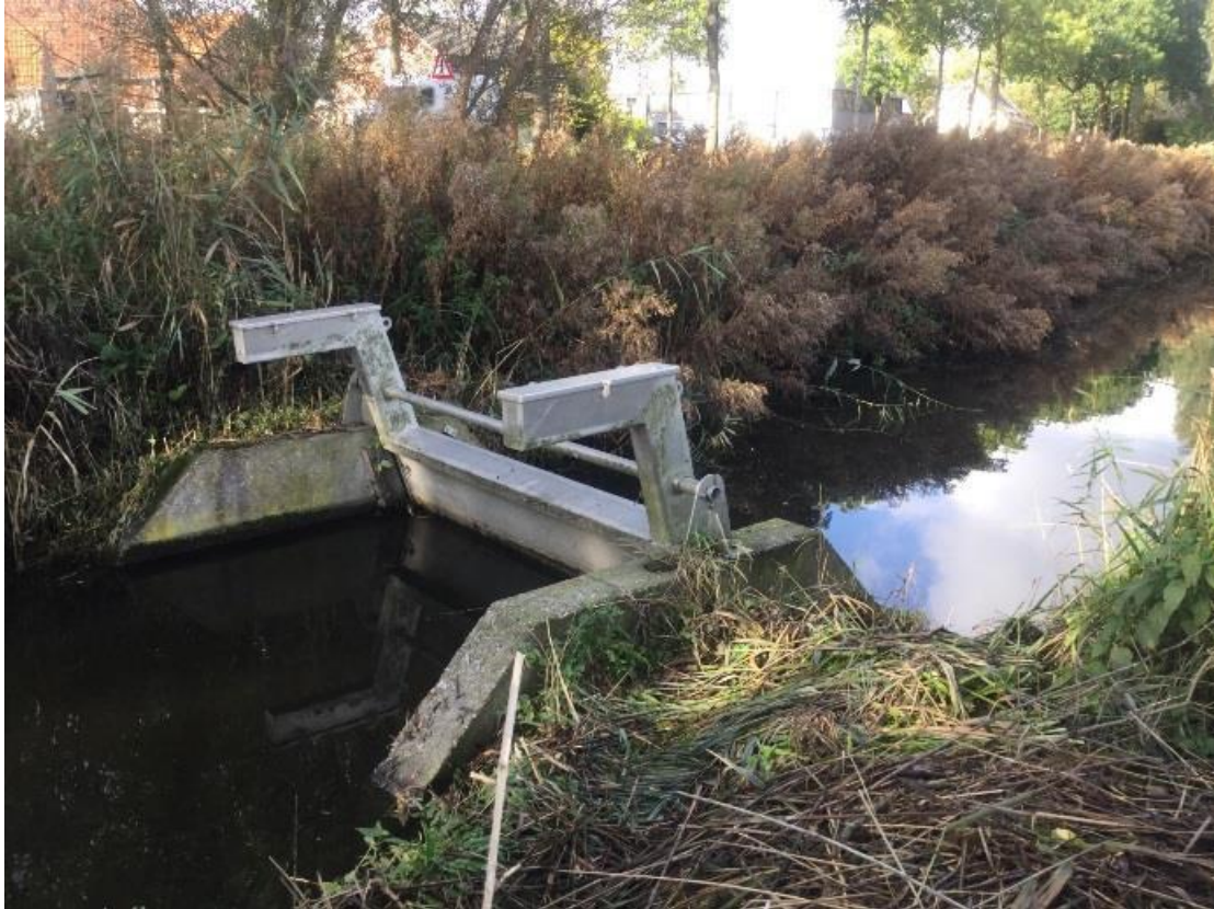
Afbeelding 4.1 Terugslagklep lange water
