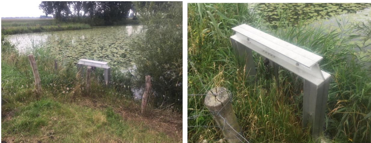
Figuur 8 Inlaat vloedspui
