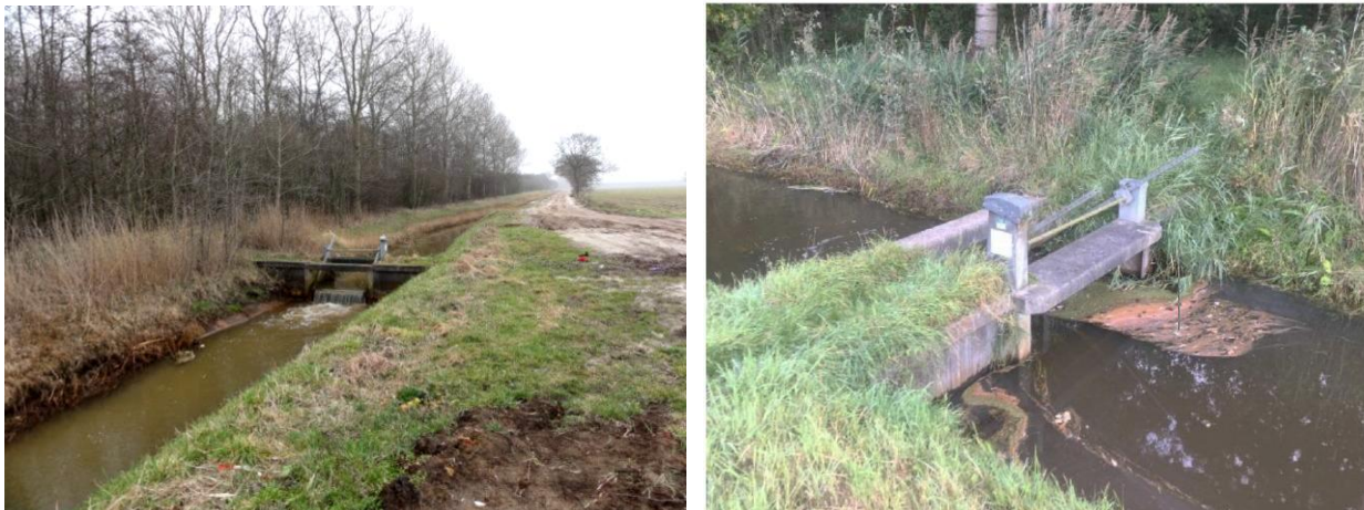
Figuur 6 Stuw Rekken
