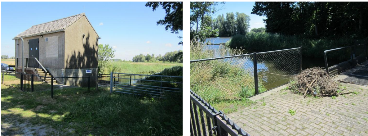
Figuur 13 Voor- en achterzijde van het gemaal
