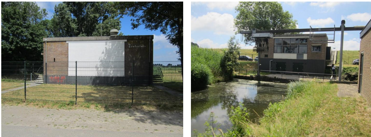
Figuur 11 Voor- en achterzijde gemaal
