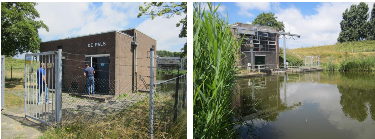
Figuur 9 Voor- en achterzijde gemaal
