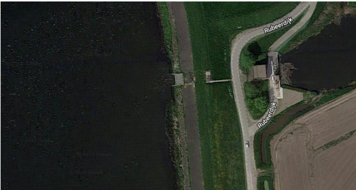
Figuur 3.17: gemaal De Pals
