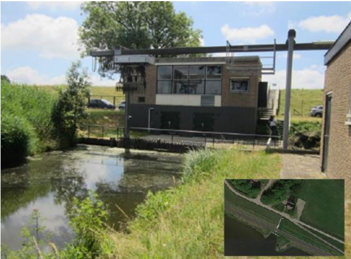
Figuur 2.3: gemaal Zoute Sluis
