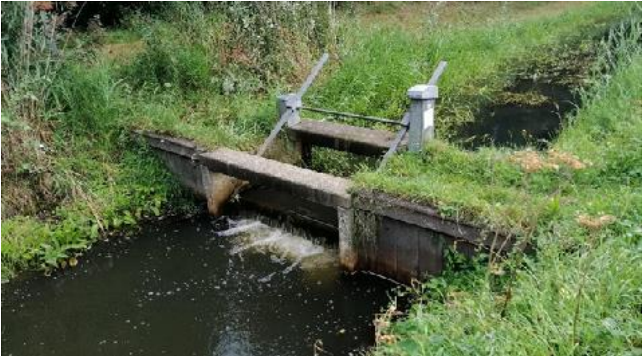
Figuur 2.11: stuw Rekken
