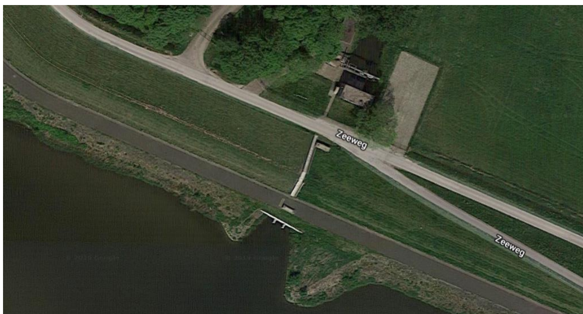
Figuur 3.20 : gemaal Zoute Sluis
