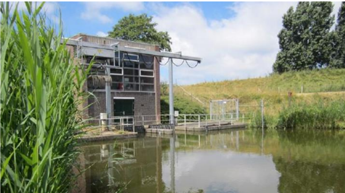
Figuur 2.6: gemaal De Pals
