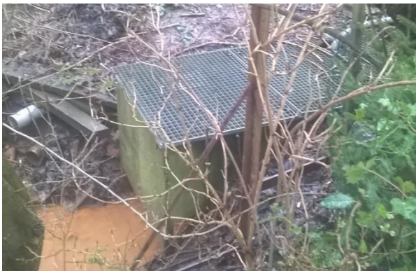
Afbeelding 5: Gemaal 'De Rollen'
