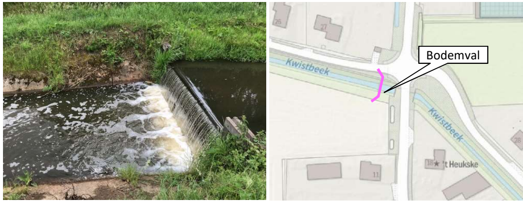
Figuur 4-30: Vervangen in- en uitstroomvoorziening
