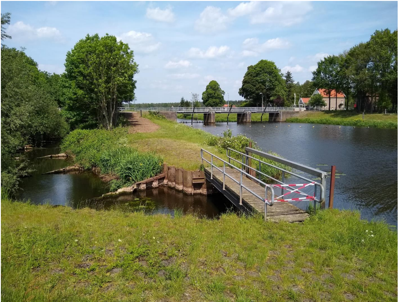
Figuur 2: Stuw Junne in huidige situatie met aan de linkerkzijde de vistrap
