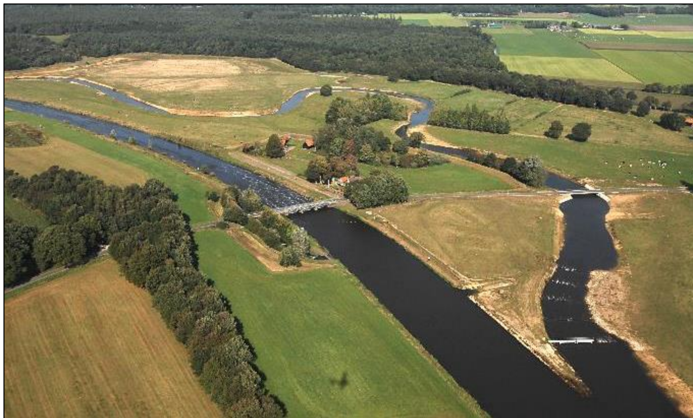
Figuur 12: Luchtfoto stuw en nevengeul
