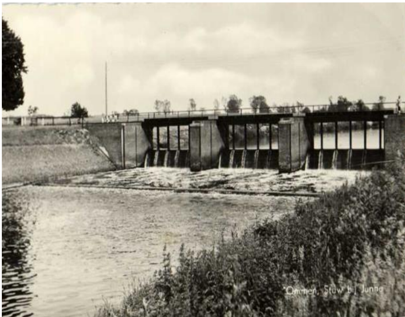
Figuur 3: Oorspronkelijke stuw (jaren dertig van de vorige eeuw) met schotten voor peilsturing
