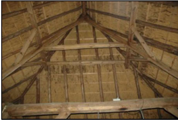
Afb. @ [LB]: Binnenkant van het voorste dakvlak met het A-vormige bovenjuk.
