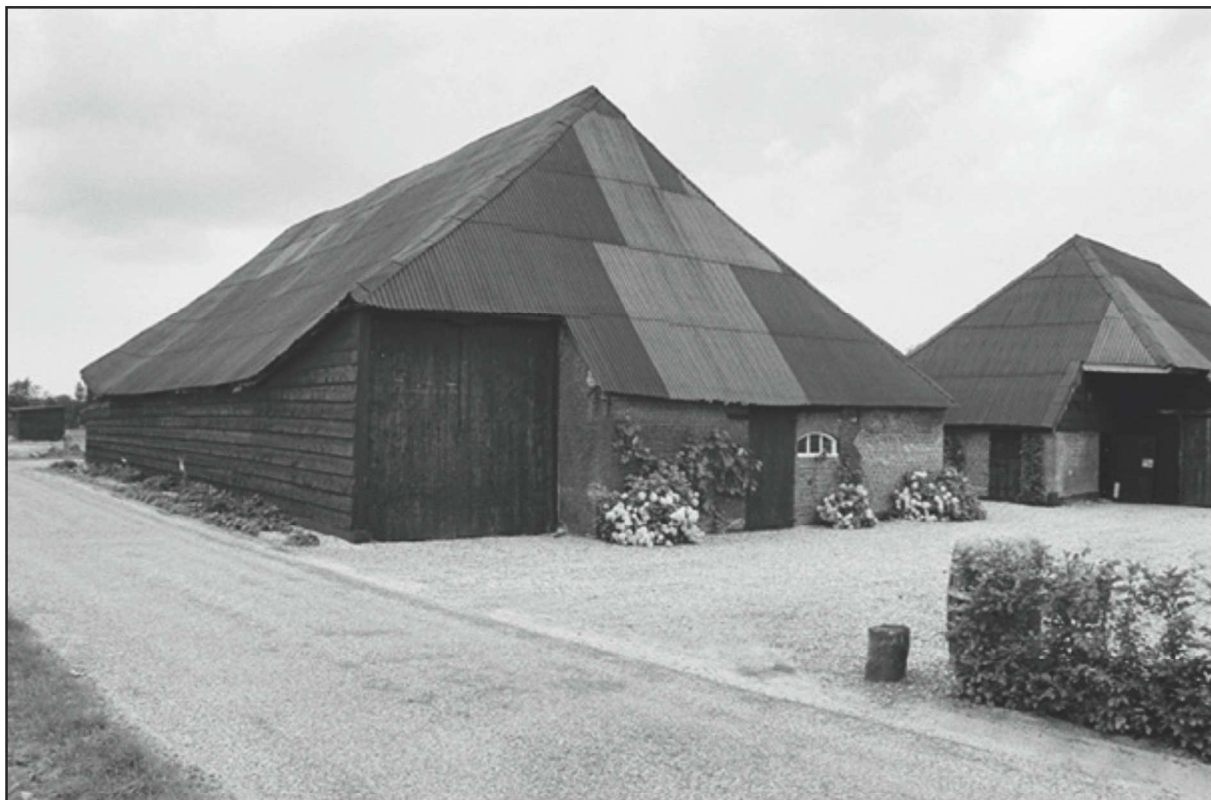
Afb. @: De beide schuren in 1988, ruim voor de renovatie. De golflaten lagen over de rieten daken heen. De oostgevel van de grote schuur bezat nog een kleine deur in het midden.
