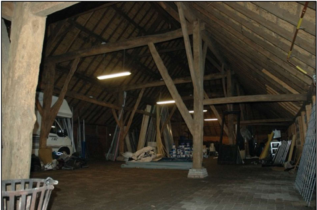
Afb. @: Het inwendige van de grote schuur van noordoost naar west. De camper illustreert mooi de functie van de zuidbeuk met, historisch, de langsdeel. Dat voertuig past niet in de andere zijbeuk.
