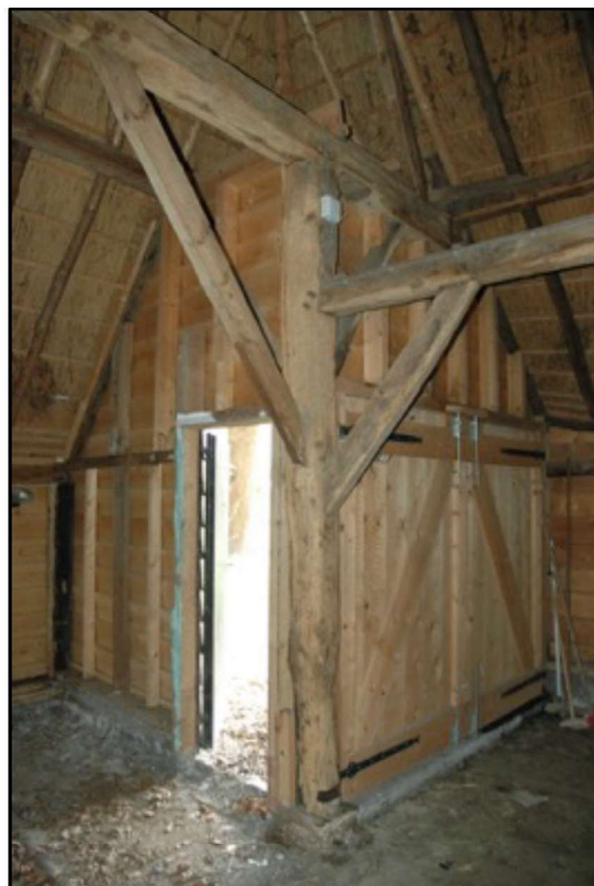
Afb. Stijl van het derde gebint rechts, zuidzijde ( IIII ) en noordzijde ( IIII ? ).
