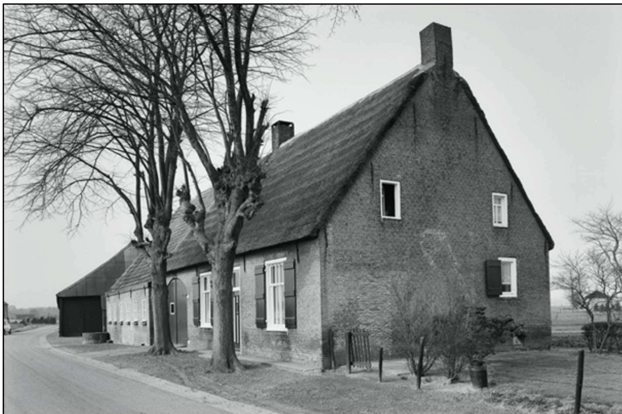
Afb. @: Foto van het oudste gedeelte van het hoofdgebouw uit 1976 eveneens door [REDACTED] met op de invulling van de ramen. Op de achtergrond een stukje van de grote schuur. [RCE]
