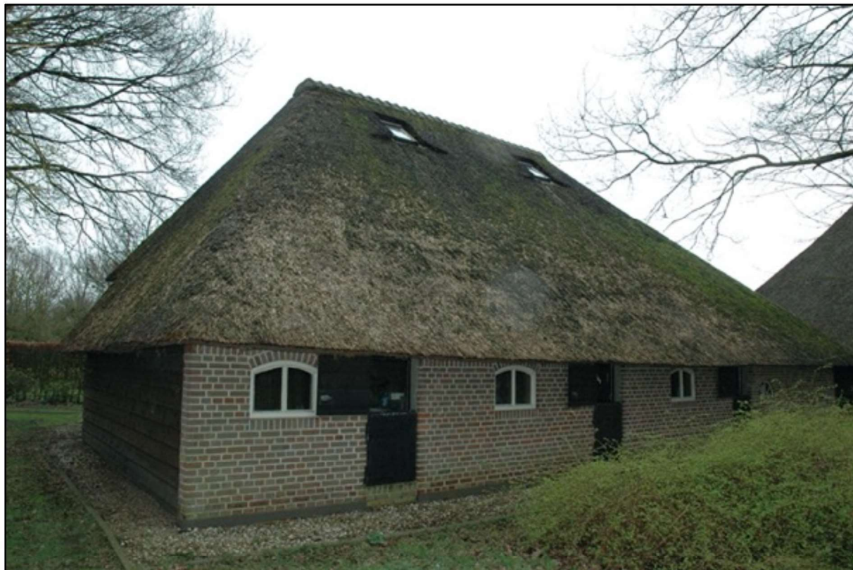
Afb. @: De linkse of oostgevel.
