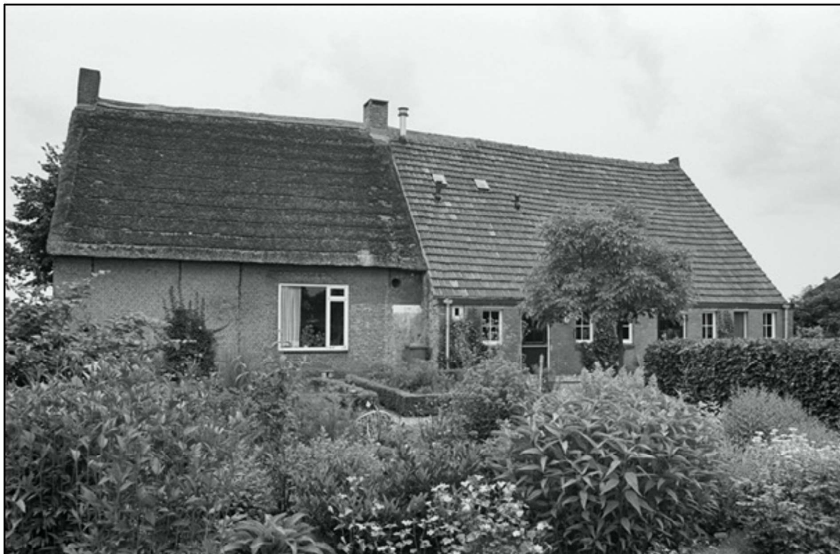
Afb. @: De achtergevel van het hoofdgebouw in 1988, vergelijk dit met het huidige beeld (afb. @). [RCE]
