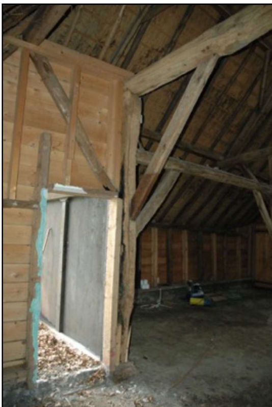
Afb. Stijl van het derde gebint rechts, zuidzijde ( IIII ) en noordzijde ( IIII ? ).
