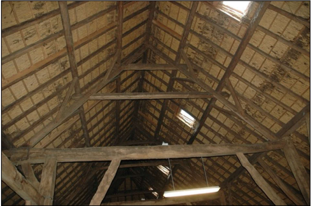
Afb. @: Boven de middenbeuk, een van de A-spanten waarvan het hout overwegend oud is.
