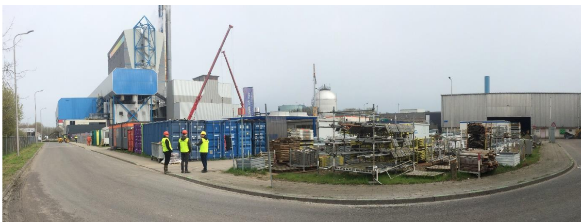
Afbeelding 2.1: Huidige locatie grootschalige opslag voor contractanten; bouw CO 2 -afvanginstallatie is reeds gereed
