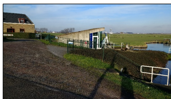
Foto 4: Locatie van de nieuw aan te leggen vispassage. Van de reeds aanwezige vispassage (linksachter gemaal) naar aanwezige Meyberg-stuw (achter wit hek).
