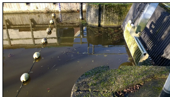
Foto 5: Gemaal en viswering Aalkeet-Binnenpolder.
