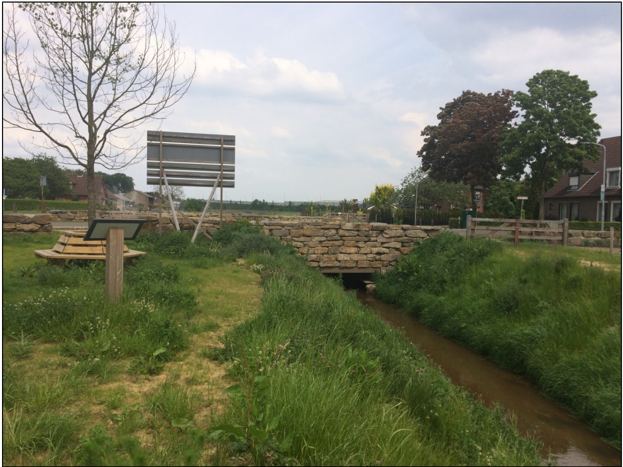
Foto duiker aan de Geliskensdijkweg in de Everlose Beek in kader van 'Herinrichting Everlose Beek – Maasmonding'
