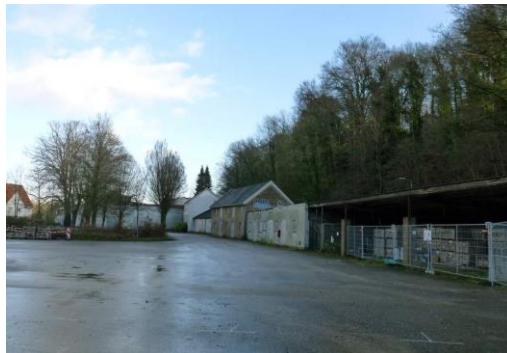
Foto 12. Overzicht westelijk deel van het plangebied met gebouwen 1 t/m 5, en de steilrand op de achtergrond.
