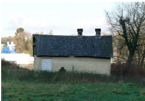
Foto 5. Gebouw 14. Dit gebouw wordt gesloopt.
