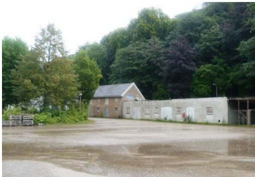
Foto 11. Gebouw 3, 2 en 1 van links naar rechts. Gebouw 1 en 2 worden gesloopt.
