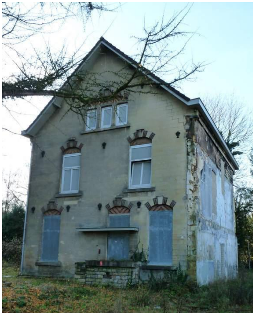
Foto 13. Gebouw 6, de vervallen vrijstaande villa achterop het terrein, waar renovatie plaatsvindt.
