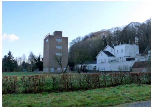
Foto 2. De te slopen toren, gebouw 13, gezien vanaf de aanvoerweg aan de Prins Bernhardlaan, met de steilrand op de achtergrond.
