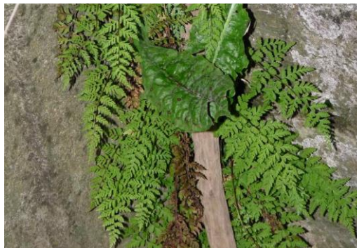
Foto 8. Zwartsteel op een kademuur bij de oostkant van de Molentak.
