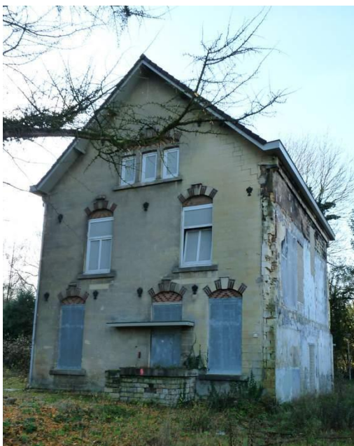
Fig. 26. Gebouw 6, waar renovatie plaatsvindt.
