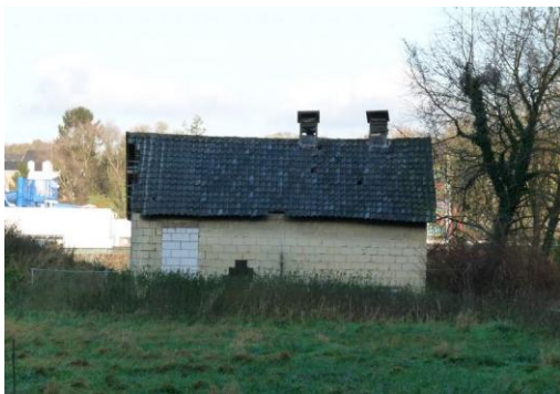
Fig. 10. Gebouw 14. Dit gebouw wordt gesloopt.
