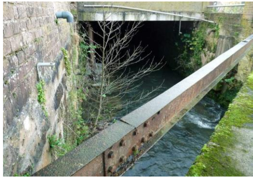
Fig. 13. Aftakking van de Geul, die onder de voormalige brouwerij door loopt, en aan de andere kant weer wordt toegevoegd aan de Geul.
