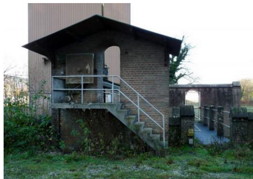
Fig. 11. Gebouwtje bij de sluis aan de zuidkant van de Geul, nabij gebouw 11 en 12.
