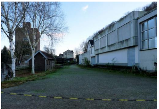
Fig. 16. Overzicht oostelijk deel van het plangebied, met rechts gebouw 10 en links gebouw 13 op de achtergrond.
