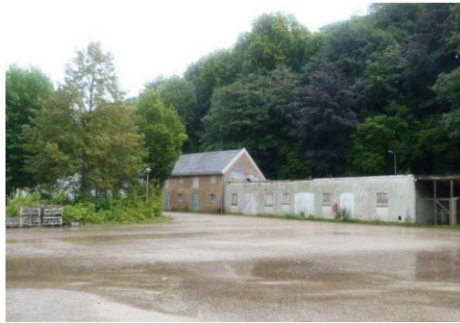
Fig. 25. Gebouw 3, 2 en 1 van links naar rechts. Gebouw 1 en 2 worden gesloopt.
