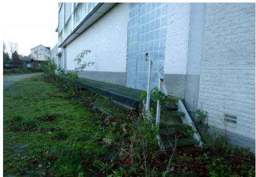
Fig. 17. Detail gebouw 10. Brug langs het gebouw. Dit gebouw wordt gesloopt.
