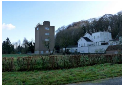
Fig. 7. De te slopen toren, gebouw 13, gezien vanaf de aanvoerweg aan de Prins Bernhardlaan, met de steilrand op de achtergrond.
