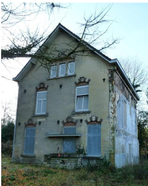
Fig. 26. Gebouw 6, waar renovatie plaatsvindt.
