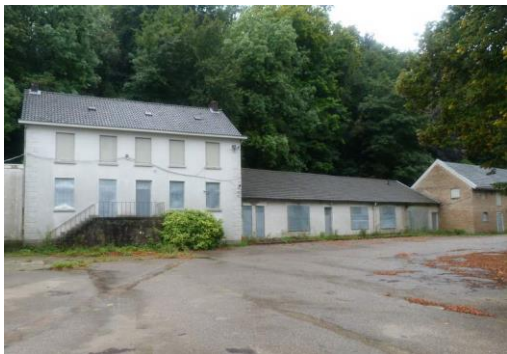
Fig. 24. Gebouw 5, 4 en 3 van links naar rechts. Bij deze gebouwen vindt dakrenovatie plaats.
