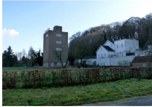
Fig. 7. De te slopen toren, gebouw 13, gezien vanaf de aanvoerweg aan de Prins Bernhardlaan, met de steilrand op de achtergrond.
