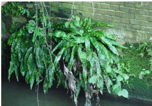
Fig. 14. Tongvarens op een kademuur van de aftakking van de Geul, onder het gebouw door.
