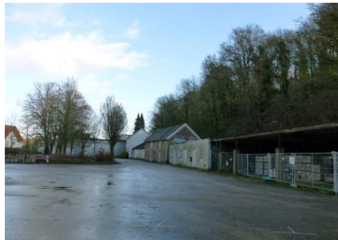
Fig. 23. Overzicht westelijk deel van het plangebied met gebouwen 1 t/m 5, en de steilrand op de achtergrond.
