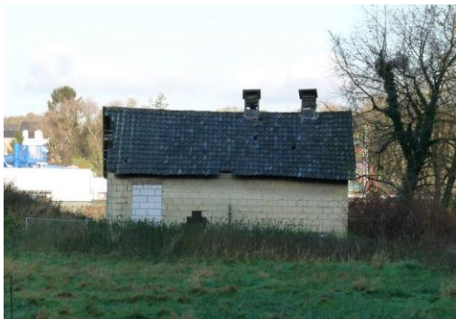
Fig. 10. Gebouw 14. Dit gebouw wordt gesloopt.
