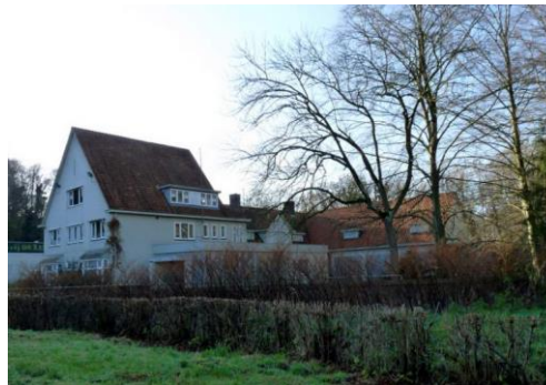
Fig. 5. Gebouw 7, gezien vanaf de aanvoerweg aan de Prins Bernhardlaan.
