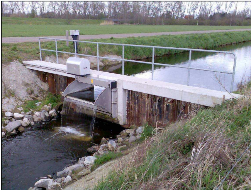
Figuur 15 Voorbeeld kantelstuw, bron: instructieboek kunstwerken waterschap WBD
