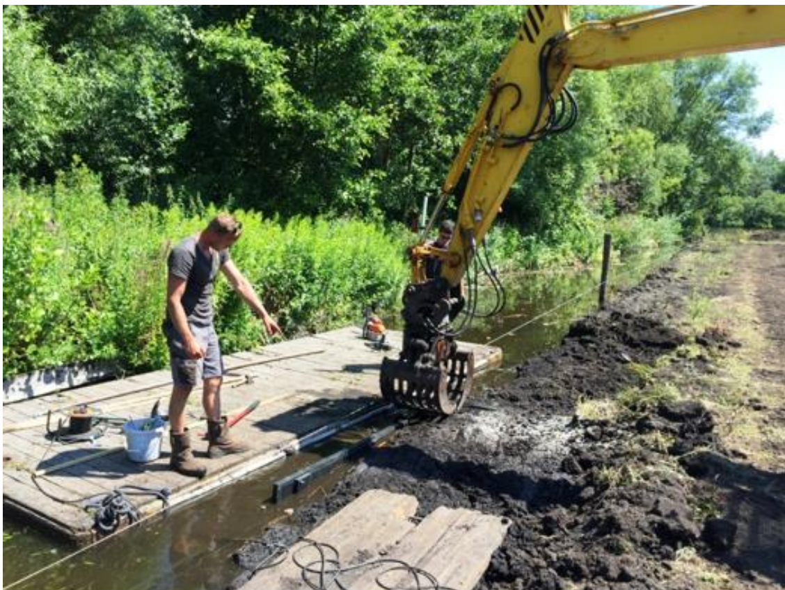
Aanleg lage beschoeiingen noordoostzijde perceel
