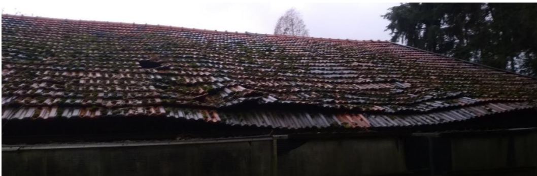
Dak van de (kippen-)schuur
