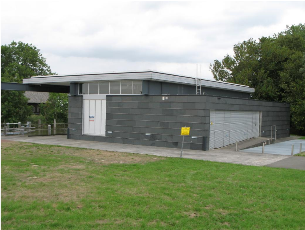
Foto's 1 & 2: boven: het gemaal, kijkend richting het noorden. Onder: de zijkant van het gemaal, kijkend richting het oosten (foto's A&W).
