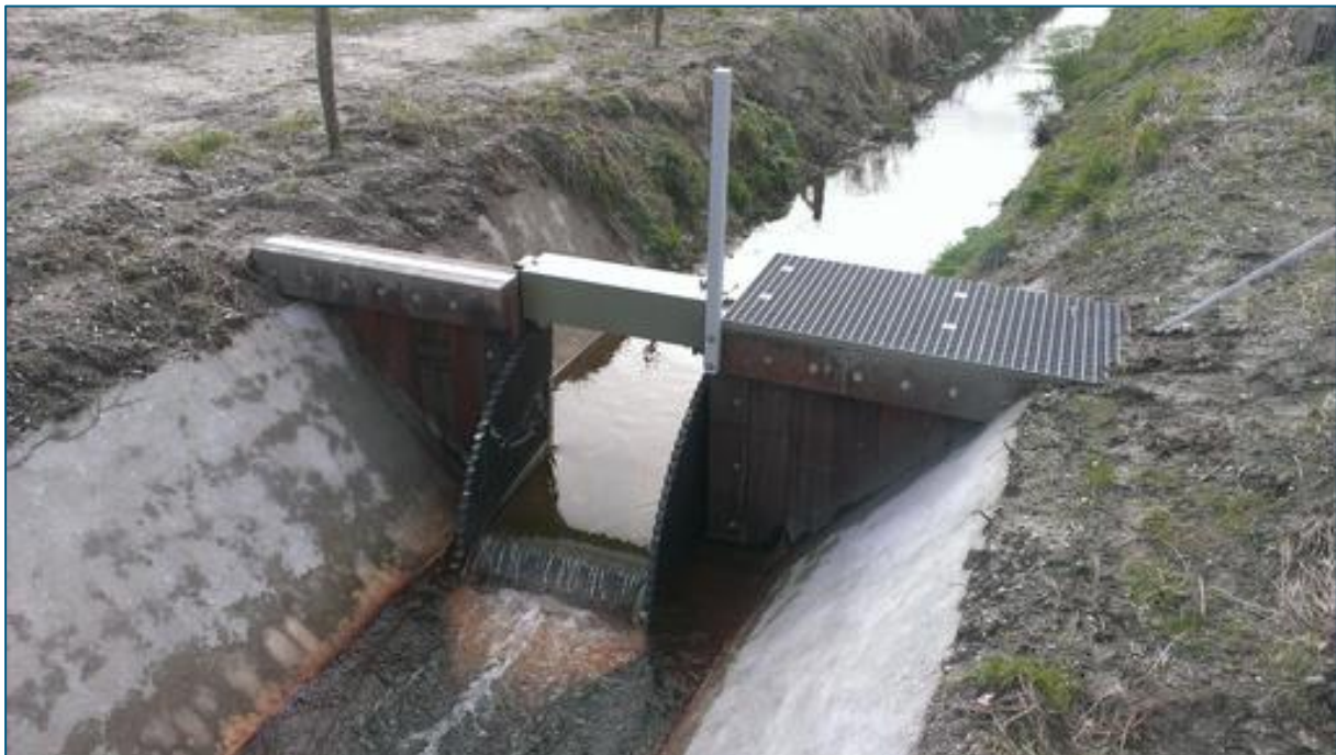
Figuur-6 Voorbeeld van kantelstuw
