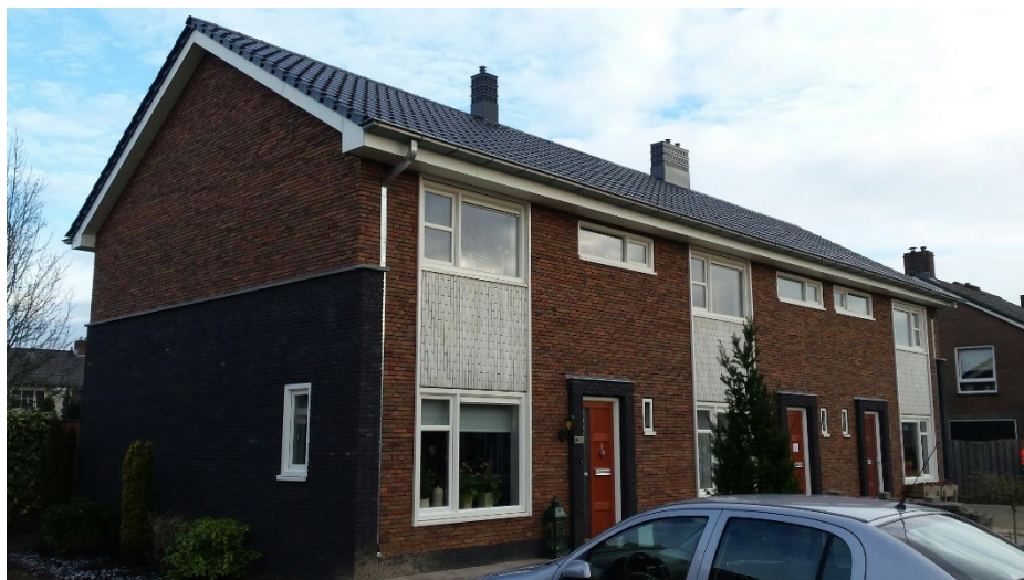
Gerenoverde woningen Borculo (De Koppel)
