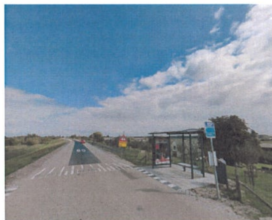
Abri voorzien van verlichting
