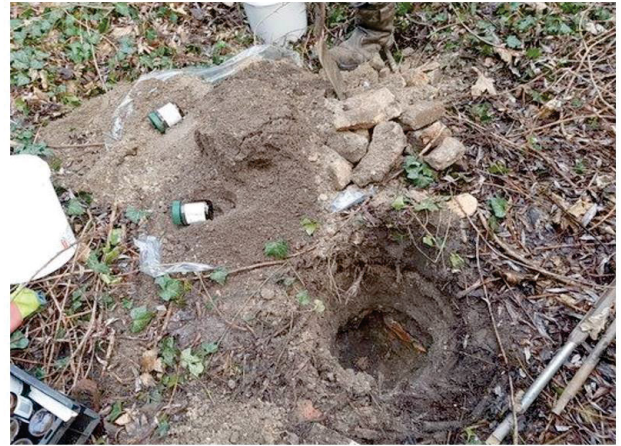
Fotonummer: 2 Omschrijving: Proefgat 103a inclusief uitgegraven materiaal.
