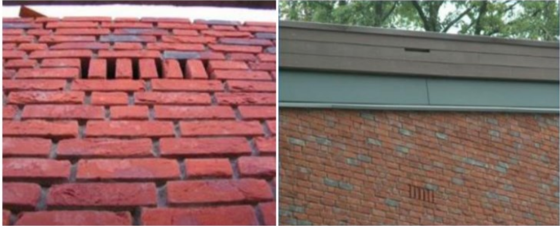
Figuur 7. Uitvoeringsvoorbeeld openingen spouwmuur met open stootvoegen.
