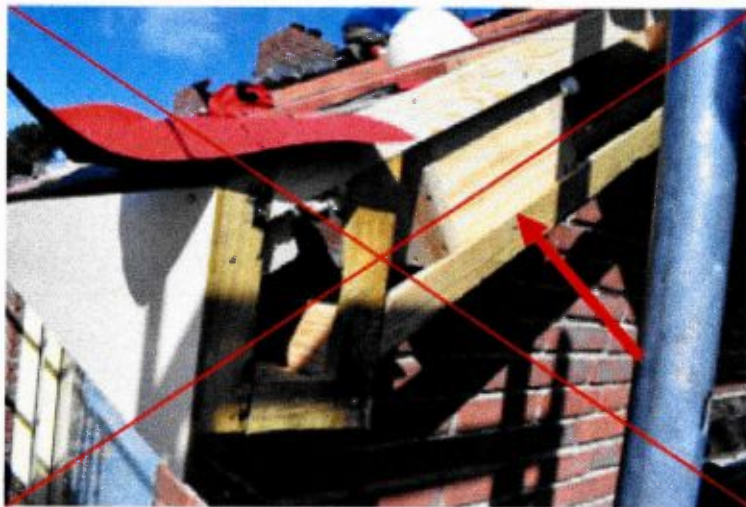
Figuur 3.10 Inbouwkast onder een schuine hoek, niet geschikt voor gierzwaluw, mogelijk nog wel voor de rugmus.
