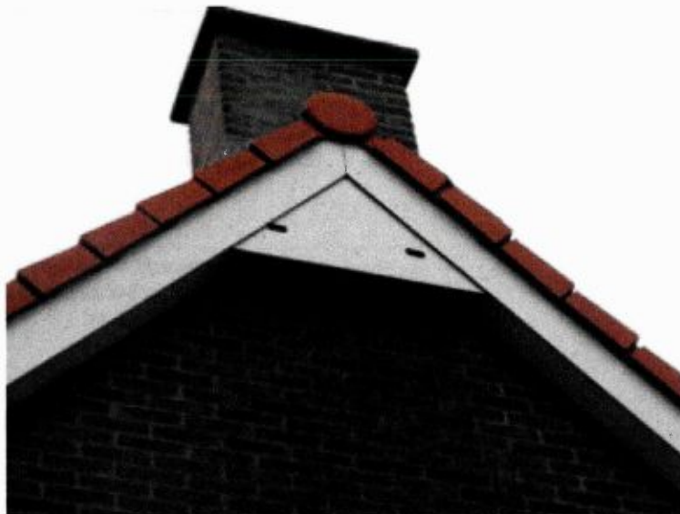
Figuur 3.5 Gierzwaluwvoorziening in nok. Op zijkant een vergelijkbare unit, maar dan voor vierkanten. Hierdoor blijft de architectonische eenheid bewaard.
