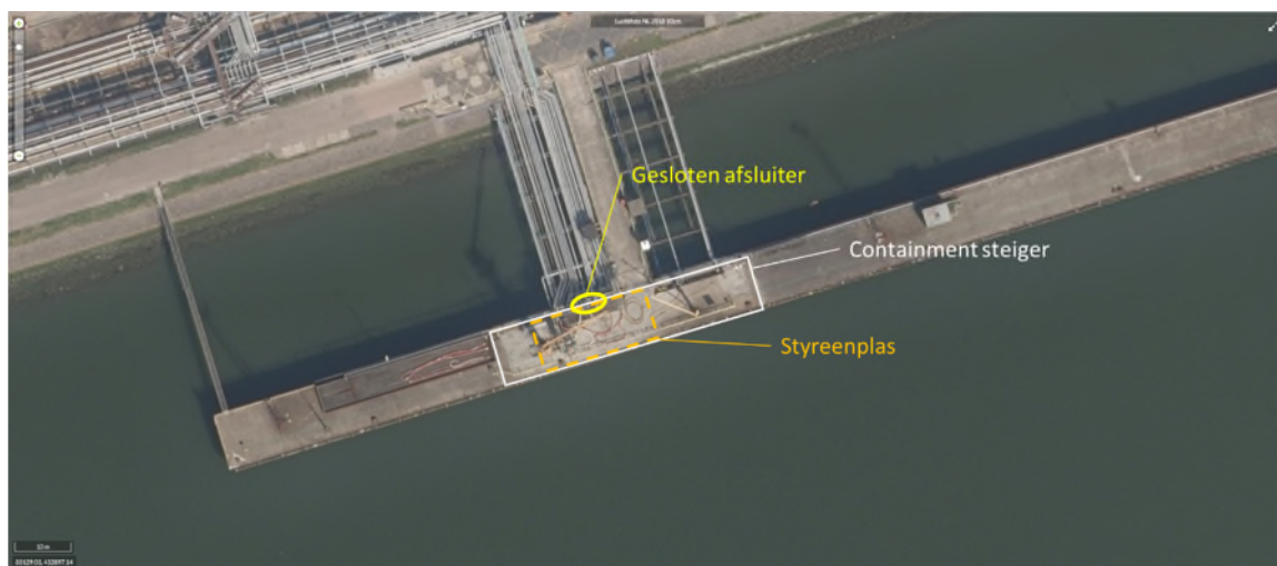
Figuur 3-7 lekkage onder pompdruk – ontstane styreenplas (oranje gestippeld omkaderd)
