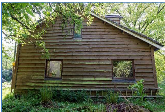
De planken gevelbetimmering geeft toegang tot ruimtes voor gebouwbewonende vleermuizen.
