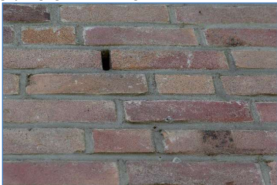
De open stootvoegen geven toegang tot ruimtes voor gebouwbewonende vleermuizen.
