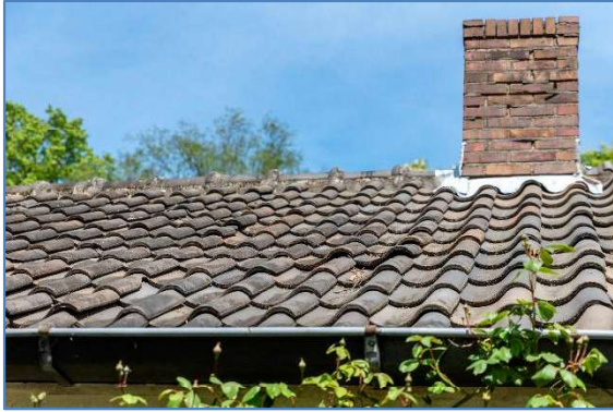
De openstaande dakpannen geven toegang tot ruimtes voor gebouwbewonende vleermuizen.
