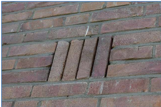
De beluchtingsleuven geven toegang tot ruimtes voor gebouwbewonende vleermuizen.
