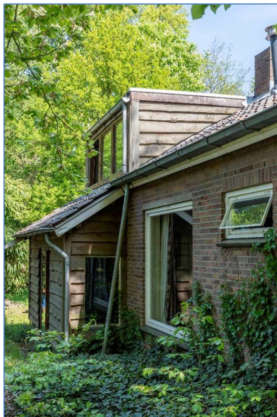
De planken gevelbetimmering geeft toegang tot ruimtes voor gebouwbewonende vleermuizen.
