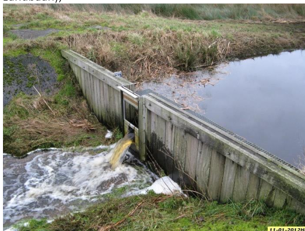
Figuur 15 Huidige stuw in deelgebied 1.
