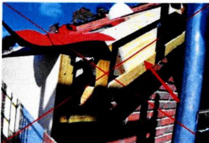
Figuur 3.10 Inbouwkast onder een schuine nok. Niet geschikt voor gierzwaluw, mogelijk nog wel voor de huismys.
