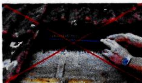
Figuur 3.3 Bij zachte isolatedaken moet een folie worden toegepast om schade te voorkomen.
