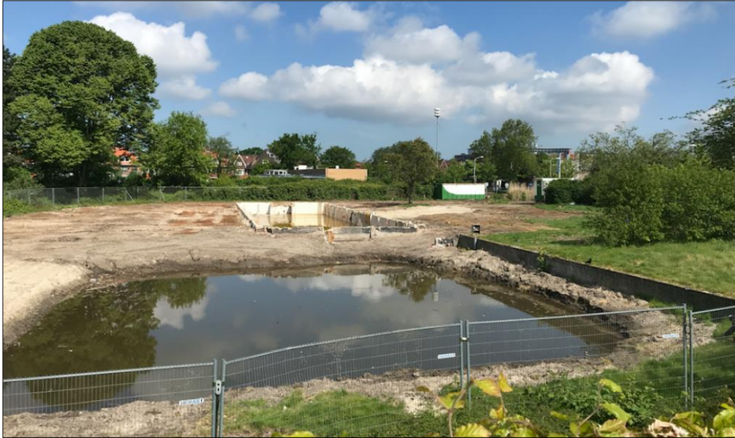
Figuur 2. Impressie van de te dempen waterpartij ter hoogte van de bouwput van het oude Kinderdagverblijf in het zuidwesten van het onderzoeksgebied (bron: mw. M. Smit).
