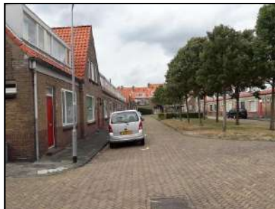
Figuur 4. Binnenhof met plantsoen en de binnenste ring met woningen op de onderzoekslocatie.
