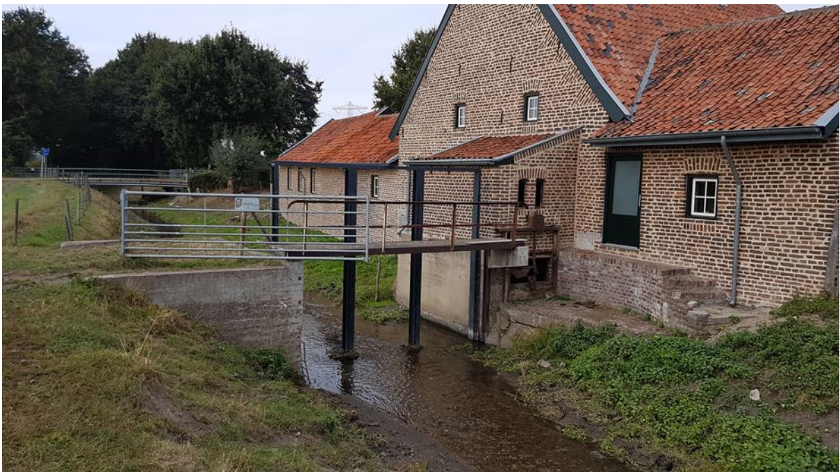
Figuur 6: Huidige situatie ter plaatse van de Dieterdermolen.
