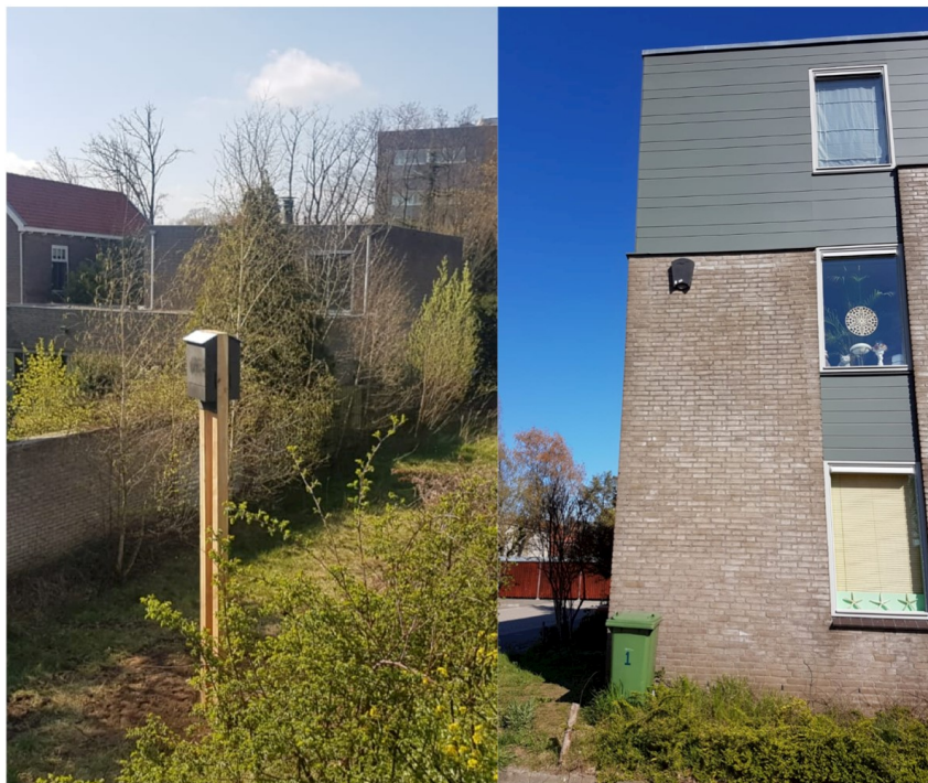
Figuur 3: Links de vleermuispaal naast het pand aan de Blecourtstraat en rechts 1 van de 8 kasten aan het Archipelhof
