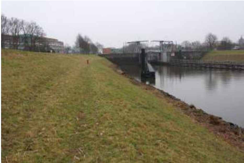
kanaaldijk en brug bij sluizencomplex
