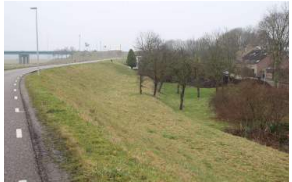
Lekdijk, aan de binnendijkse zijde verschillende typen beplanting op en langs de dijkberm
