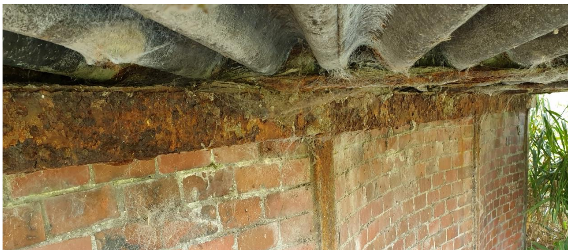
Figuur 4-2: Ruimtes tussen golfplaat onder de brug Munstertil welke mogelijk geschikt zijn als verblijfplaats voor vleermuizen (foto RHDHV).
