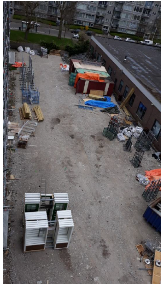
Bouwplaats inrichting, waar mogelijk worden de bestaande bomen gespaard en voorzien van boomplanken ter bescherming.
