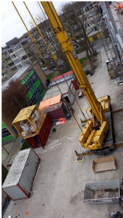
Bouwplaats, opstellocatie kraan en vaste containerplaatsen
