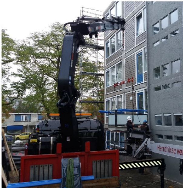
Plaatsen van nieuwe gevels en balkons m.b.v. een kraan
