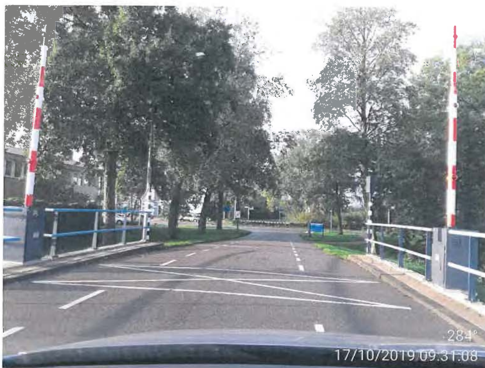
Foto BOR, Paradijsbrug
