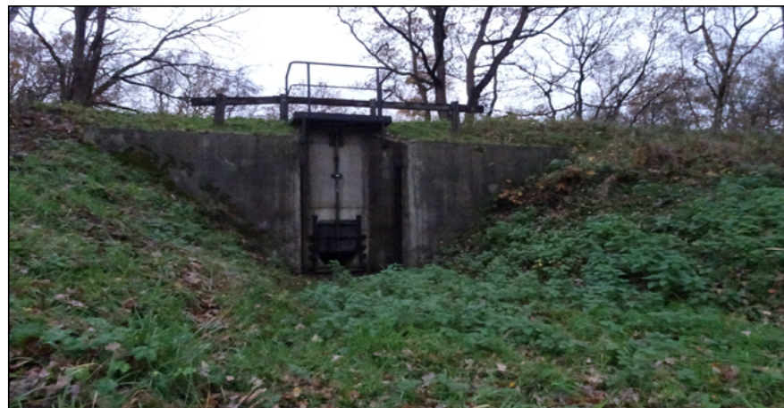
Figuur: foto KW45 noordzijde.
