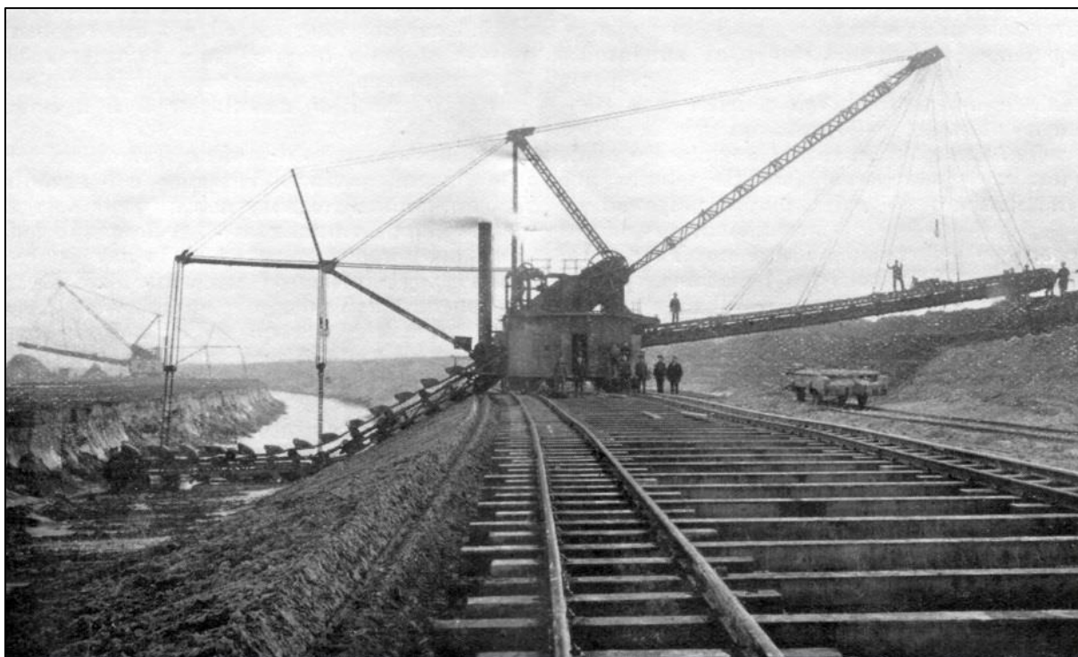
Afb. 12. Het uitgraven van het Drongelens kanaal in 1907-1910. Foto: collectie HKK Onsenoort.
