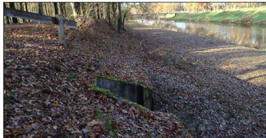
Figuur: foto KW122 noordzijde.
