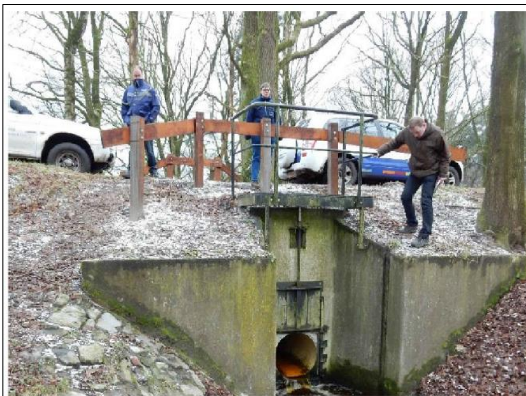
Afb. 3. Locatie 16, huidige situatie.
