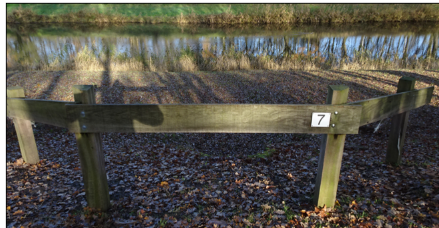
Figuur: foto KW122 noordzijde.
