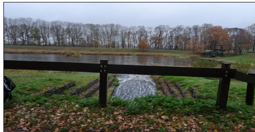
Figuur: foto KW60 noordzijde.
