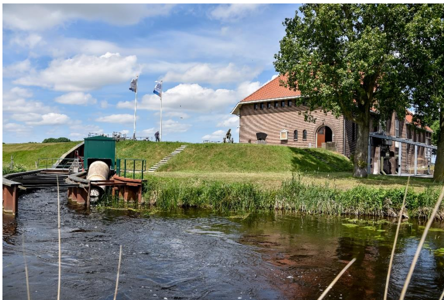
Waterinlaat bij gemaal Stroink
