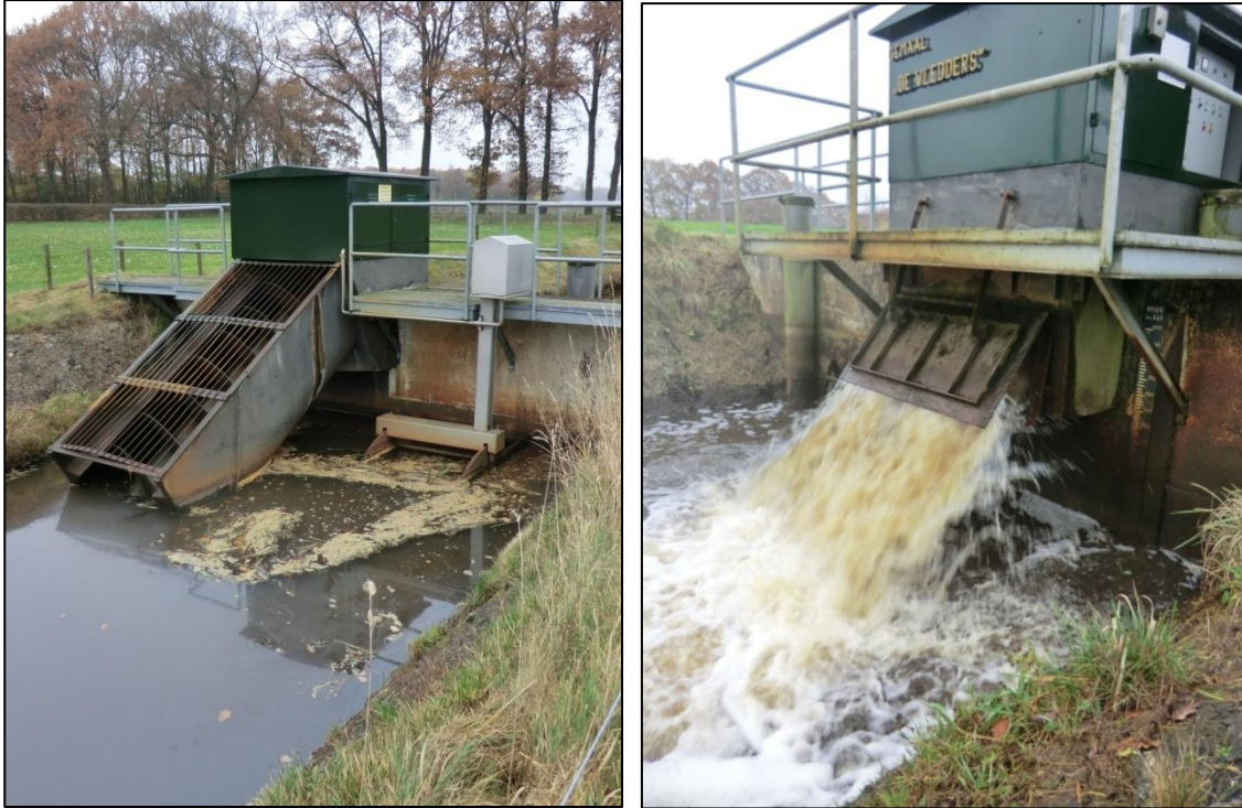
Figuur 2-9 Gemaal en stuw De Vledders
