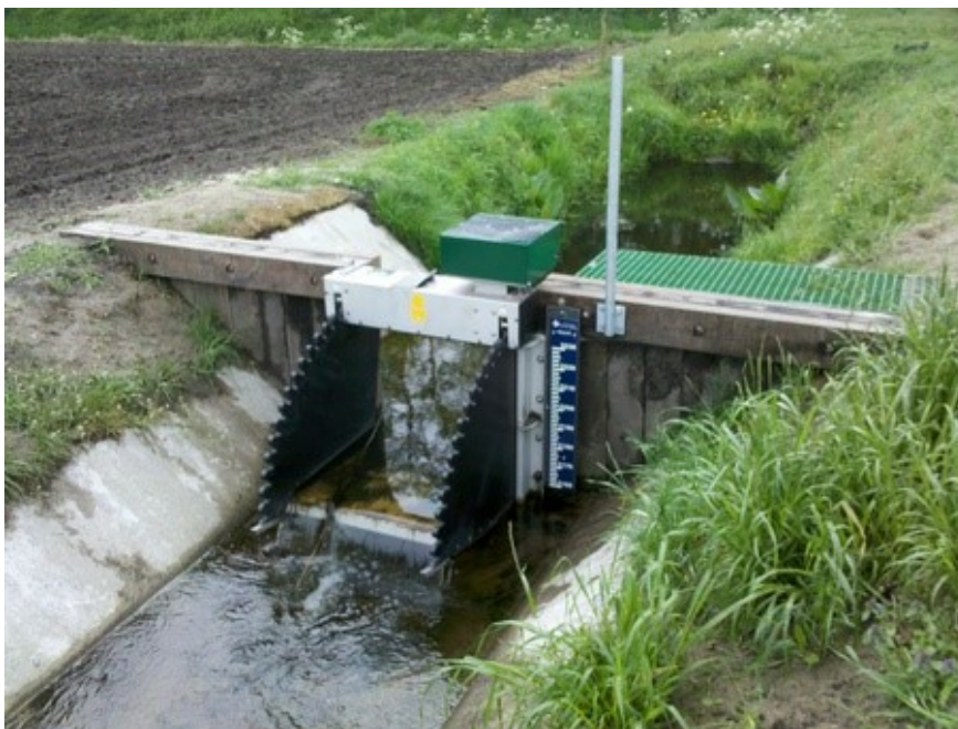
Figuur 6.1 voorbeeld van een te plaatsen kantelstuw
