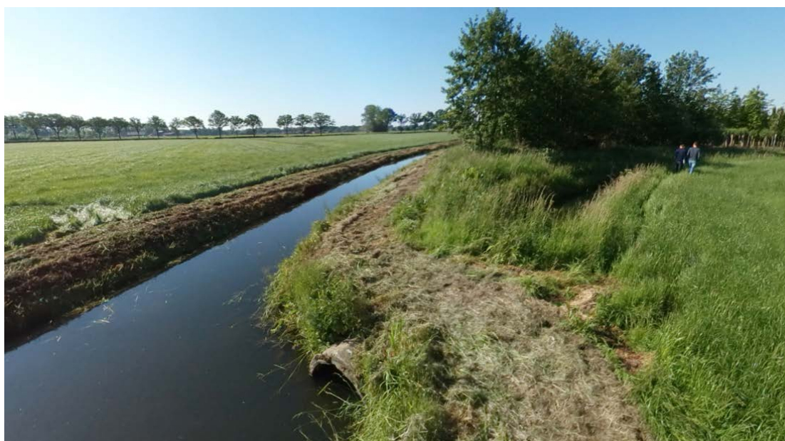
Figuur 3.5 Locatie van de nieuwe stuw in de Heijeneindsche Loop
