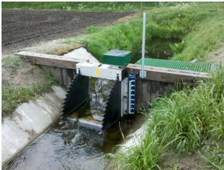
Figuur 3.2 Voorbeeld van de te plaatsen klepstuw
